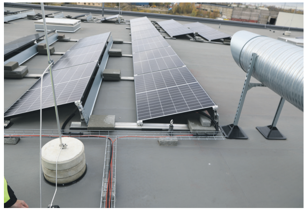
Kaablid ja juhtmed on paigaldatud vett läbilaskvatele rennidele, mis toetuvad spetsiaalsetele alustele. (Eesti). Kaablirennid võiks olla pealt kaetud. Foto: Alo Karu
