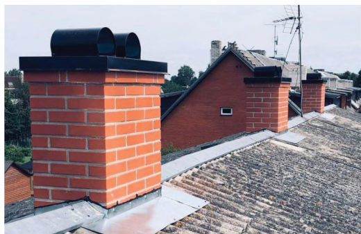
Korterühistu uued korstnakivist korstnamütsidega korstnad
