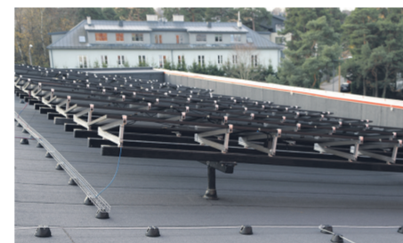
TalTech Mäemaja päikesepaneelid on paigaldatud aluskonstruktsioonidele toetuvatele pollaritele. See tekitab küll marginaalsed külmaküljed, kuid võimaldab korrektselt katuse hooldust. Hoonel on kõrgeid parapettid ja seepärast ei ole vaja ka turvaravustust.
