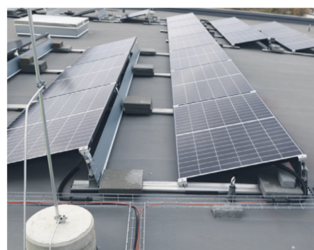
Kaablid ja juhtmed on paigaldatud vett läbilaskvatele rennidelle, mis toetavad katusele spetsiaalsetele alustele. (Eesti). Kaablirennid võiks olla pealt kaetud.
