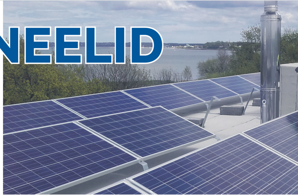
Lattrauast paneelide alus on kohati otse katusekattel. Kinnitused läbivad katusekatet. Selline paigaldusviis on katusekattetele kahjulik.
