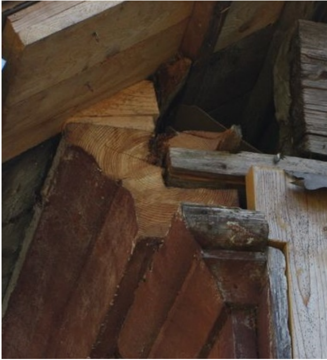
Joonis 85 – Räästakarniisi läbilõige – Vali, J fotokogu
