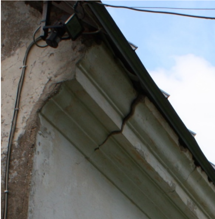
Joonis 42 – Hoone küljel välja vajunud räästakarniis – Vali, J fotokogu
