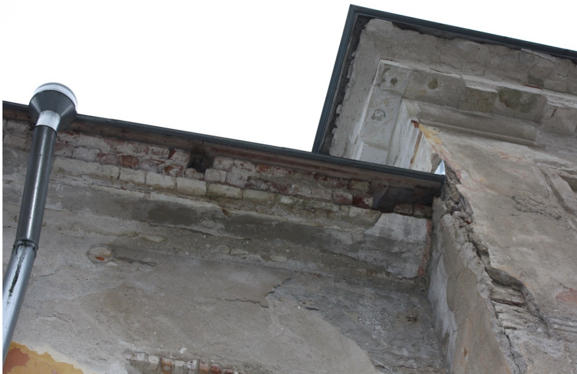
Joonis 60 – Tellistest räästakarniis paekiiviplaadil – Vali, J. fotokogu
