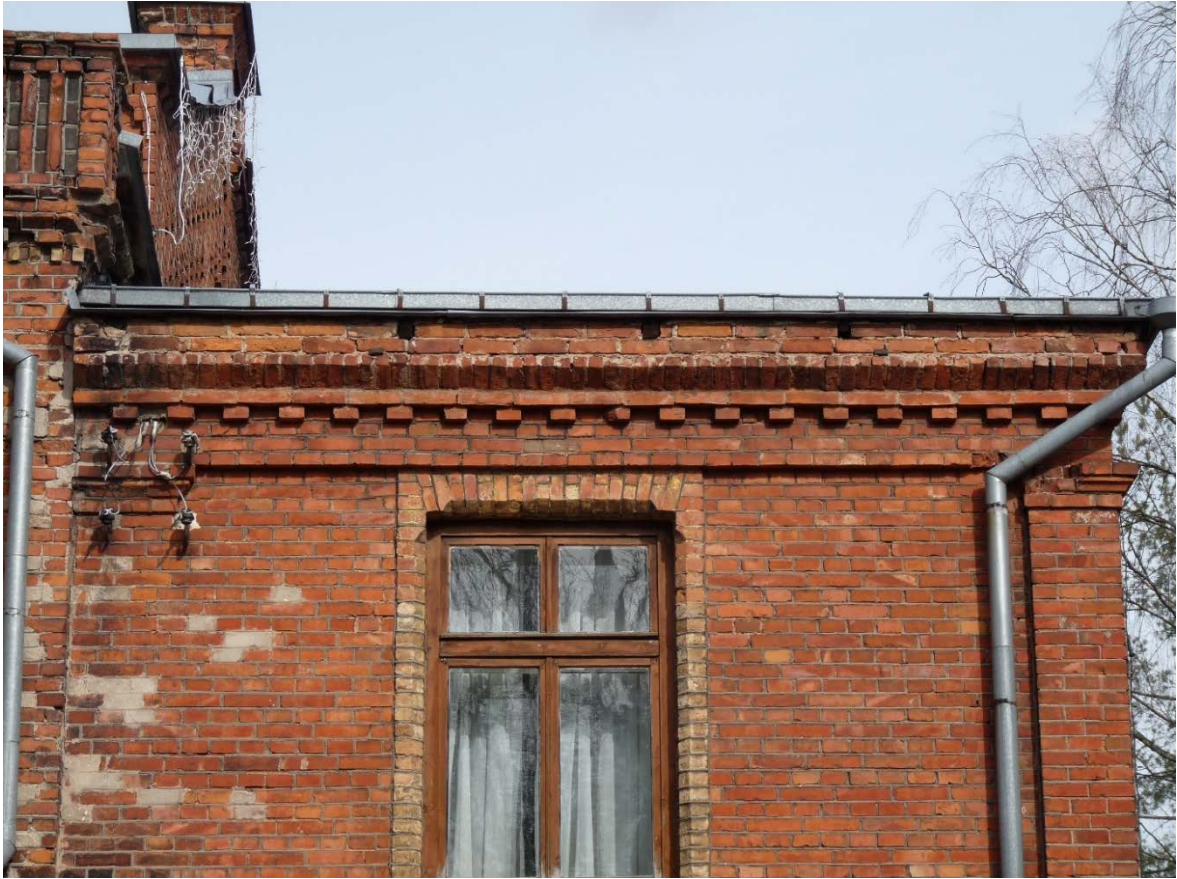
Joonis 35 – Karniisi ebaloogiline lõpetus ja sarikaotsad – Kaaret, T 10.04.2015
