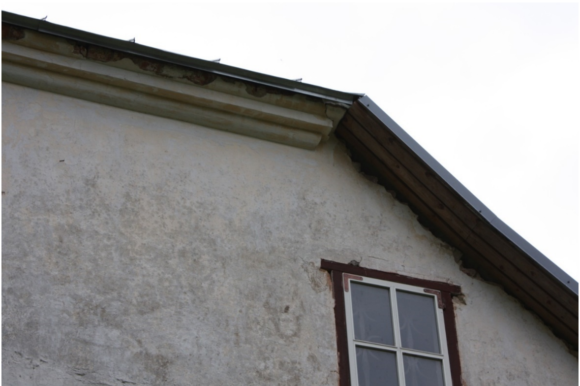
Joonis 48 – Katuse ilma karniisita viiluäär, millest katuseserv liiga kaugele üle eendub – Vali, J. fotokogu
