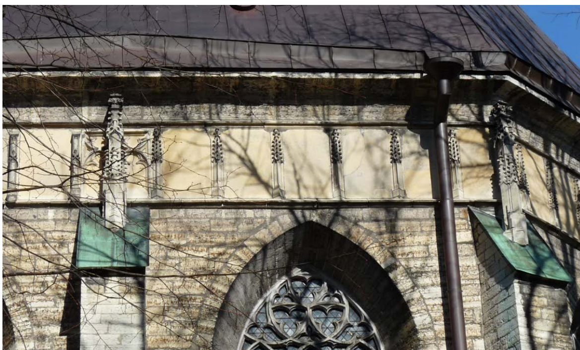
Joonis 51 – Maarja kabeli karniis ja friis – Kaaret, T. (17.03.2015)
