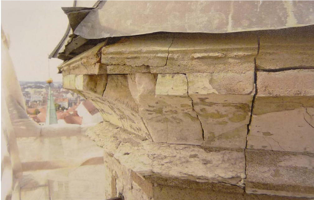
Joonis 52 – Plekk ei kaitse karniisi piisavalt – Uuetalu, 2009, n9.5524B
