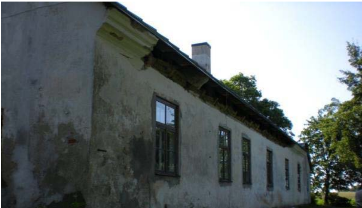
Joonis 45 – Varisenud karniis hoone lääneküljel – Niit, R. 14.07.2009
