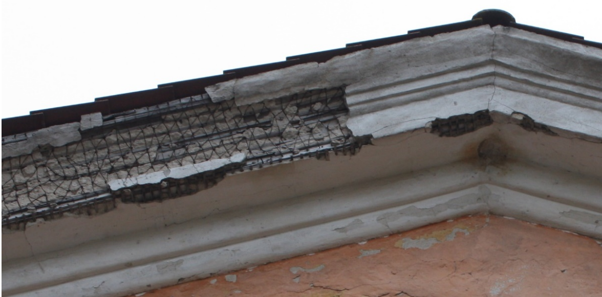
Joonis 81 – Puidul krohvitud karniis Aruküla mõisa esifassaadi kolmnurkfrontoonil – Vali, J. fotokogu
