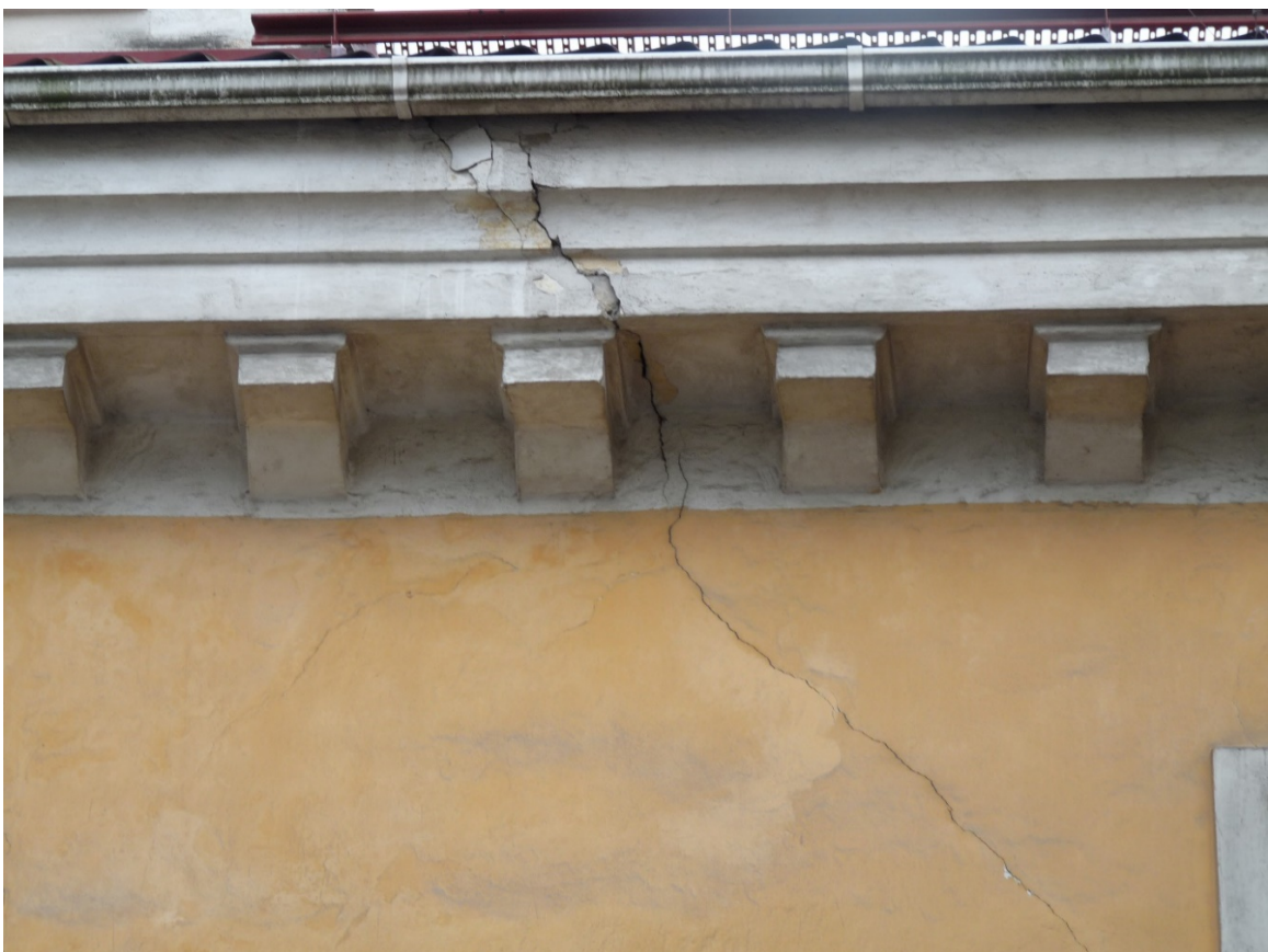
Joonis 77 – Pragu Luise tänava poolses fassaadis – Kaaret, T.13.04.2015
