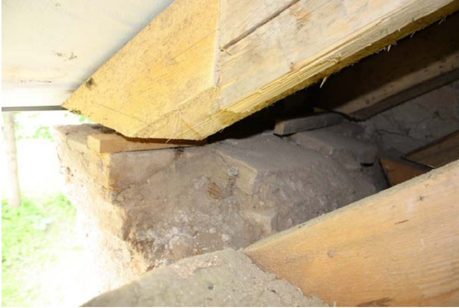
Joonis 44 – Kiilud räästatõstja ja karniisi vahel – Vali, J. fotokogu
