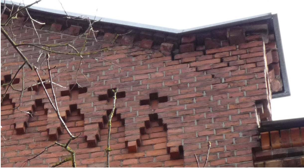
Joonis 38 – Kaldpraod viilul ja allapöördega katteplekk – Kaaret, T. 10.04.2015
