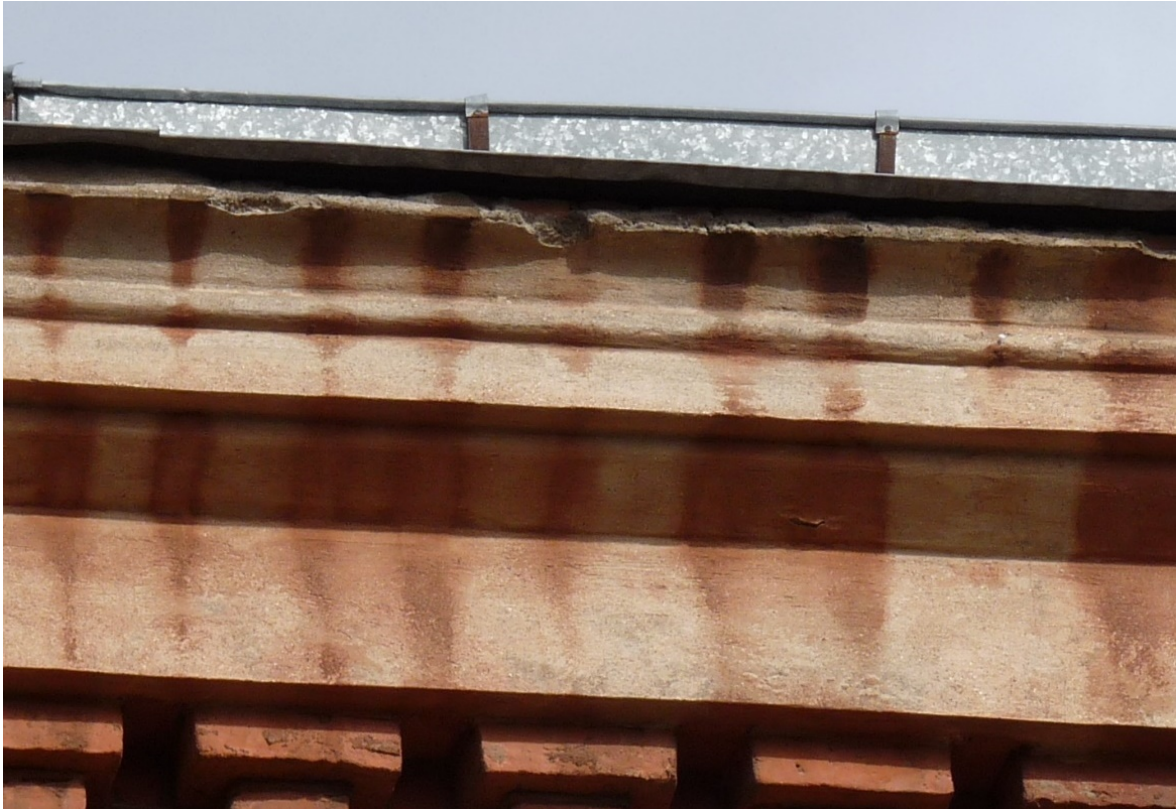
Joonis 31 – Veejäljed ja pudenenud karniisiäär – Kaaret, T. 10.04.2015
