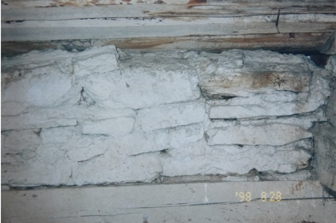
Joonis 68 – Müürilati peale on laotud neli rida paekivimüüri; tõmbtala ja sarika ots ning müürilatt on umbselt sisse pakitud – Ränd,1999
