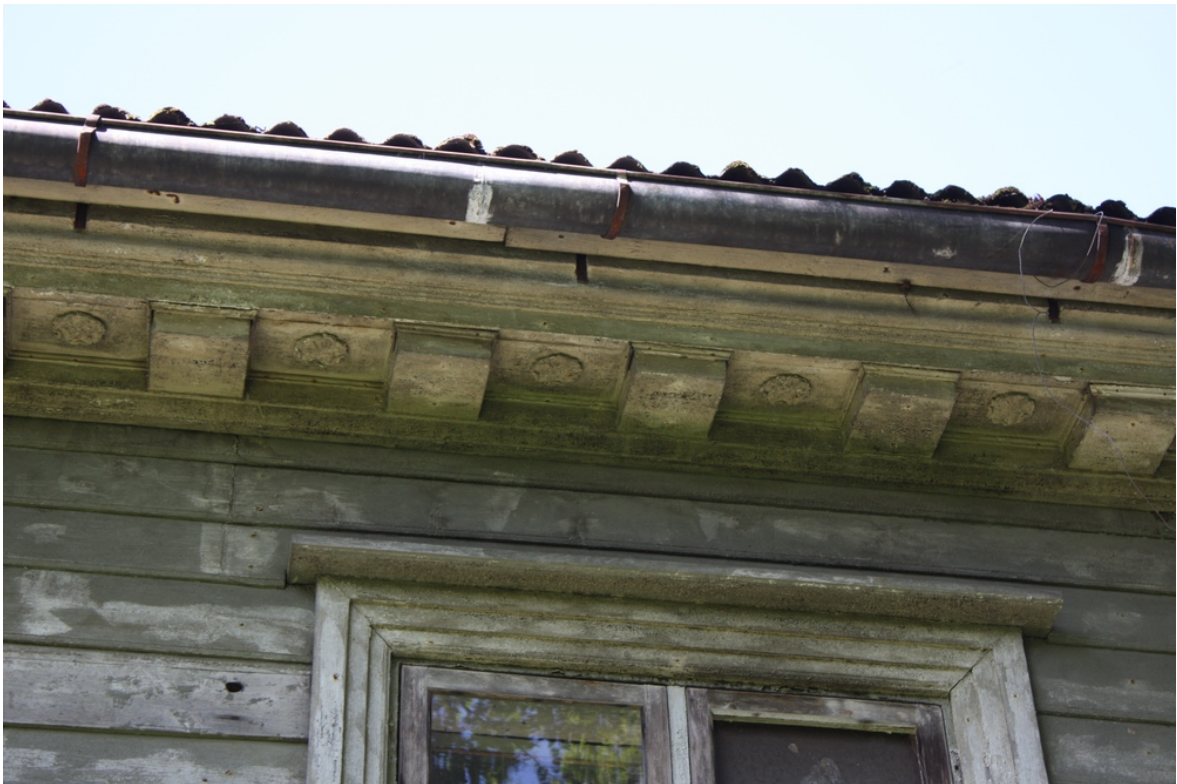
Joonis 80 – Puidust kassetide ja rosettidega karniis Einmanni mõisahooneel – Vali, J. fotokogu
