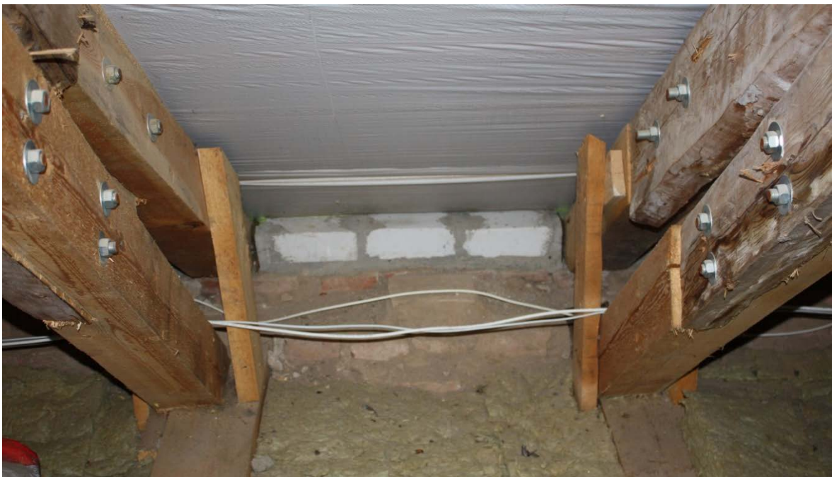
Joonis 43 – Karniisi vasturaskus asendatud soojustusmaterjaliga, karniisiäärele laotud silikaatkivid – Vali, J. fotokogu
