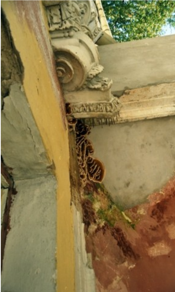
Joonis 69 – Seen Saku mõisa peahoone portikusel – Vali, J. fotokogu
