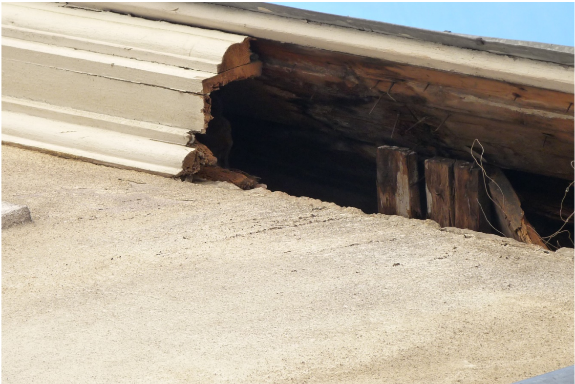
Joonis 79 – Seest tühi puidust karniis, Lai 20, Tallinn – Kaaret T. 17.03.2015
