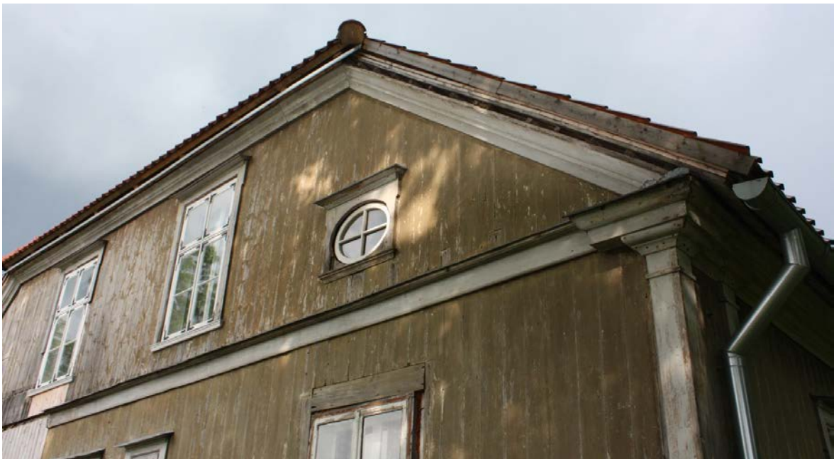
Joonis 86 – Tõusnud räästajoon – Vali, J. fotokogu
