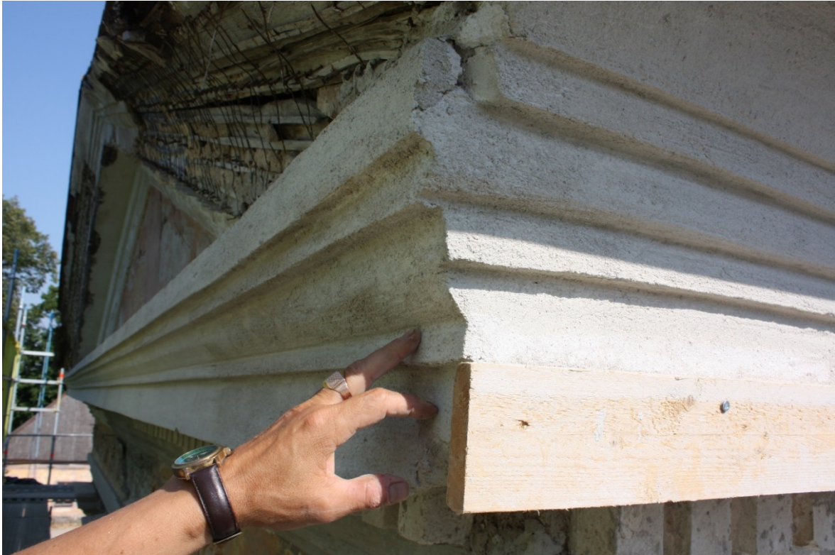
Joonis 63 – Karniisiprofiilid ei ühti nurgas – Vali, J. fotokogu
