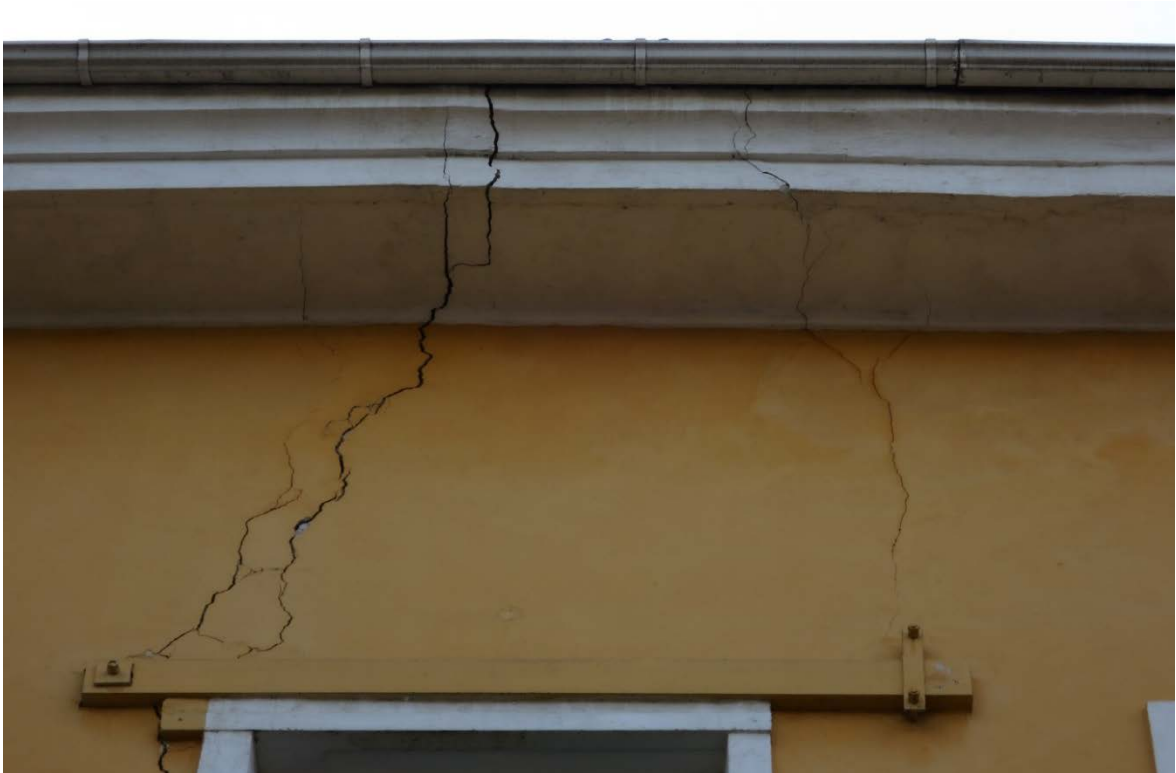
Joonis 76 – Pragu Toompuiestee-poolses otsaseinas – Idnurm, M. fotokogu
