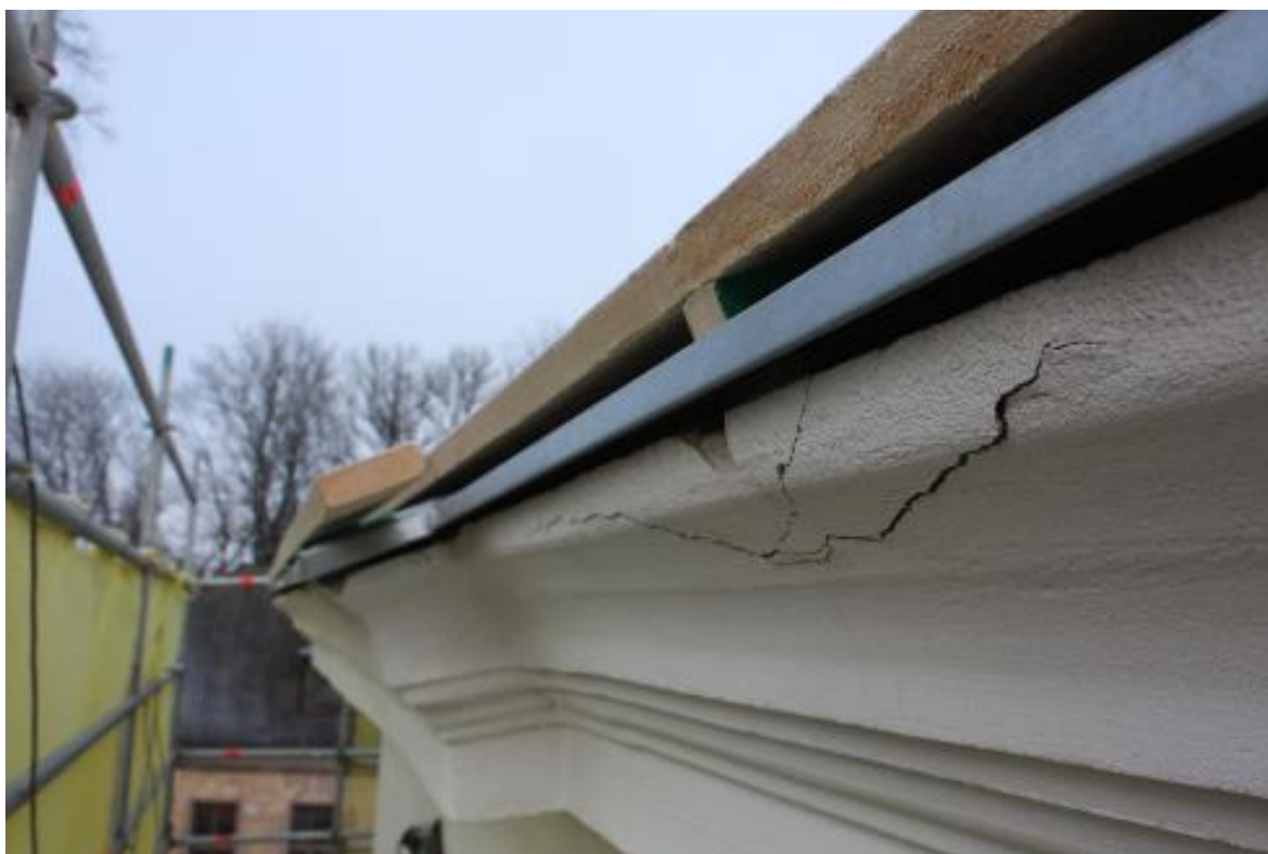
Joonis 61 – Räästatõstja liikumine lõhub vastrestaureeritud karniisikrohvi – Vali, J. fotokogu
