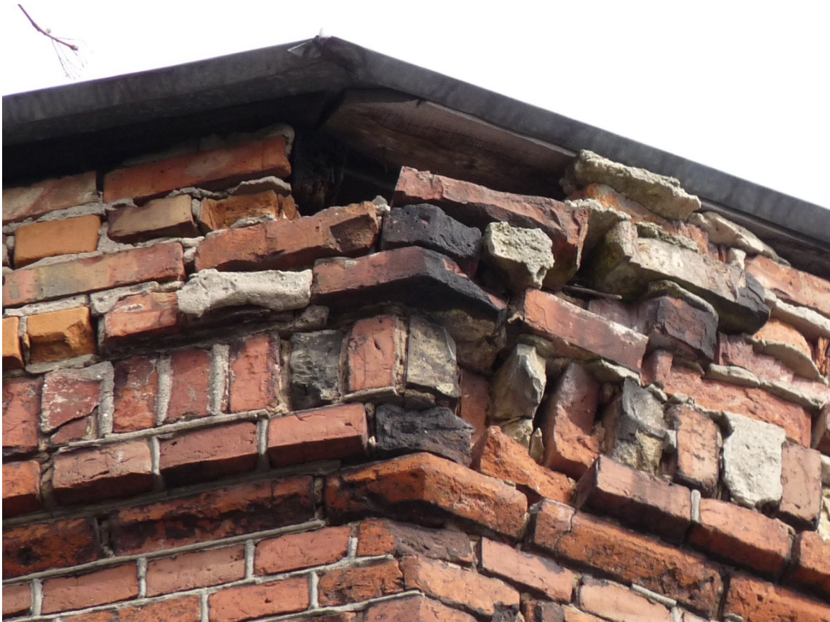
Joonis 34 – Purunenud tellised – Kaaret, 10.04.2015
