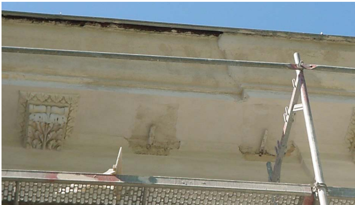
Joonis 71 – 2002, karniisi ja pleki kokkukrohvimine – Vali, J. fotokogu
