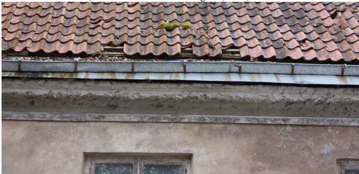
Joonis 50 – Tsementkrohviga parandatud karniis – Vali, J. fotokogu
