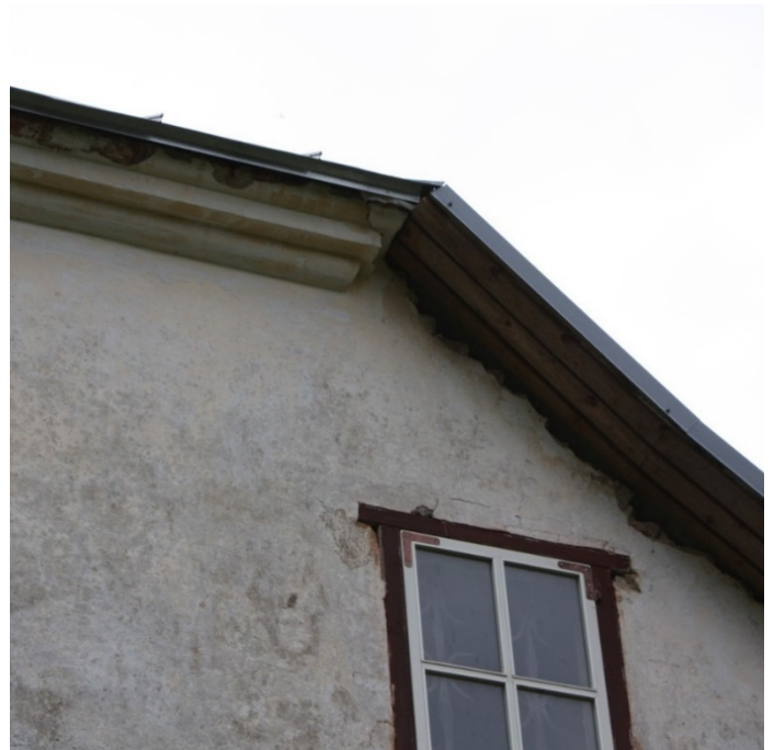
Foto 9 – Katuse karniisita viiluäär, millest katuseserv liiga kaugemale üle endub – Vali, J. fotokogu
