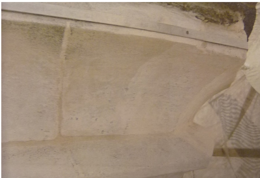
Joonis 54 – Terasest ringvöö ja Remmersi restaureerimismördiga restaureeritud karniis – Uuetalu, 2009, n9.5524B
