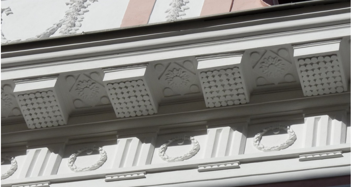
Joonis 9 – Mutul 'id gutta 'dega: Pikk 19, Tallinn – Kaaret, T. 17.03.2015
