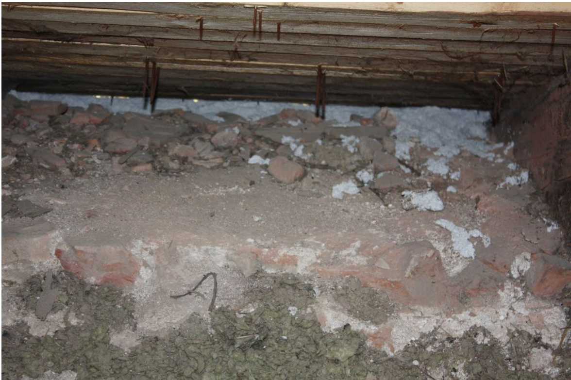
Joonis 64 – Tuulutusvahe on krohviseguga täidetud – Vali, J. fotokogu
