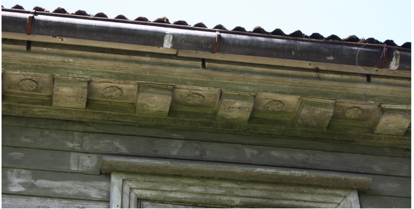
Foto 2 – Puidust kassettide ja rosettidega karniis Einmanni mõisahooneel – Vali, J. fotokogu
