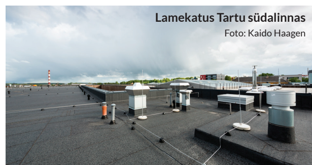
Lamekatusele avanev hoone tehniline šaht Foto: Kaido Haagen
