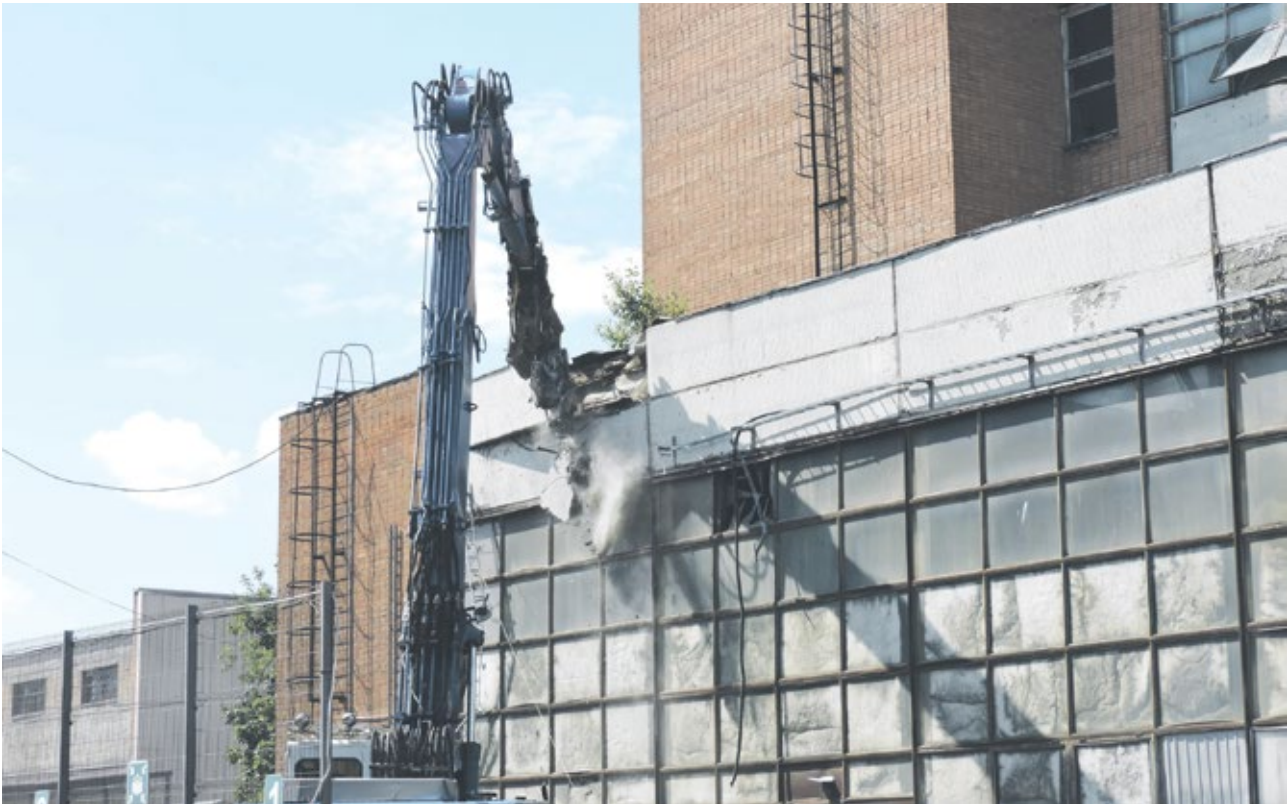
Главная цель сноса старого производственного корпуса – строительство на этом месте хорошей, современной парковки для работников завода.
