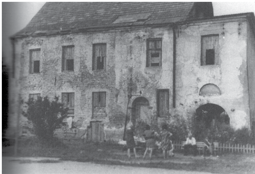
На фото здание по адресу Койдула За до реставрации.
