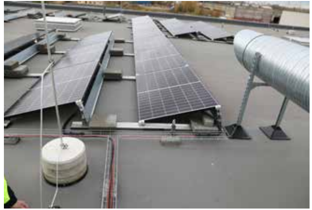
Kaablid ja juhtmed on paigaldatud vett läbilaskvatele rennidele, mis toetuvad katusele spetsiaalsetele alustele. (Eesti). Kaablirennid võiks olla pealt kaetud. Foto: Alo Karu
