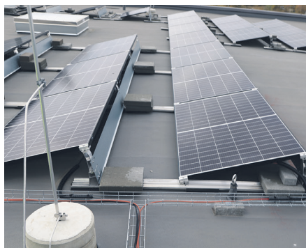
Kaablid ja juhtmed on paigaldatud vett läbilaskvate rennidele, mis toetuvad katusele spetsiaalsetele alustele. (Eesti). Kaabli rennid võiks olla pealt kaetud.
