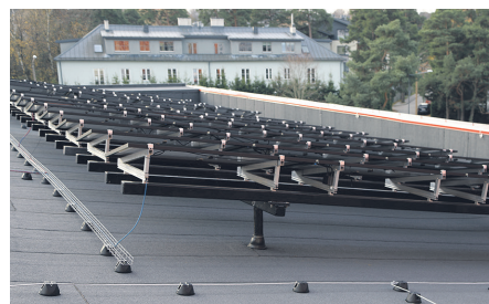
TalTech Mäemaja päikesepaneelid on paigaldatud aluskonstruktsioonidele toetuvatele pollaritele. See tekitab küll marginaalsed külmasillad, kuid võimaldab korrektset katuse hooldust. Hoonel on kõrged parapetid ja seepärast ei ole vaja ka turvavarustust.
