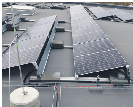
Kaablid ja juhtmed on paigaldatud vett läblaskvatele rennidele, mis toetuvad katusele spetsiaalsetele alustele. (Eesti). Kaablirennid võiks olla pealt kaetud.
