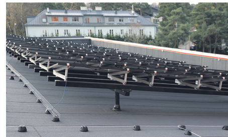
TalTech Mäemaja päikesepaneelid on paigaldatud aluskonstruktsioonidele toetuvale pollaritele. See tekitab küll marginaalsed külmasilad, kuid võimaldab korrektselt katuse hooldust. Hoonel on kõrge parapettid ja seepärast ei ole vaja ka turvaravustust.
