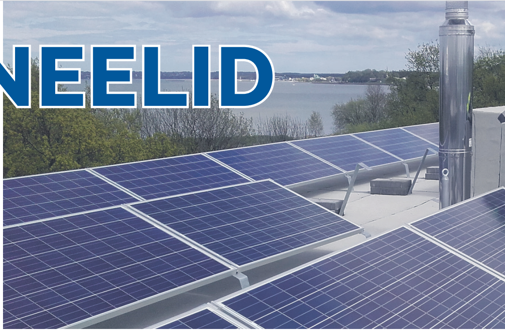
Lattrauast paneelide alus on kohati otse katusekatel. Kinnitused läbivad katusekatet. Selline paigaldusviis on katusekattele kahjulik.
