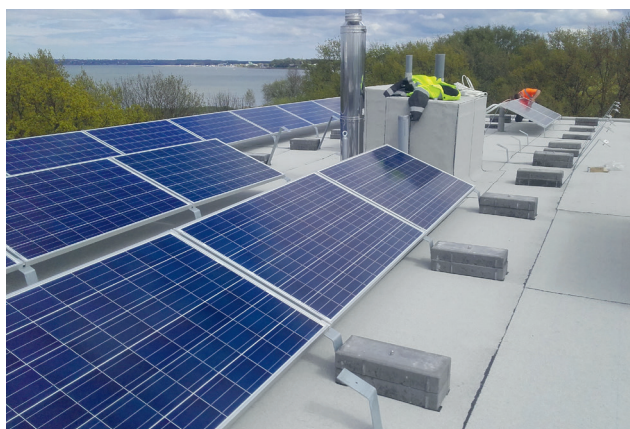
Lattrauast paneelide alus on kohati otse katusekattel. Kinnitused läbivad katusekatet. Selline paigaldusviis on katusekattele kahjulik. Foto: Alo Karu
