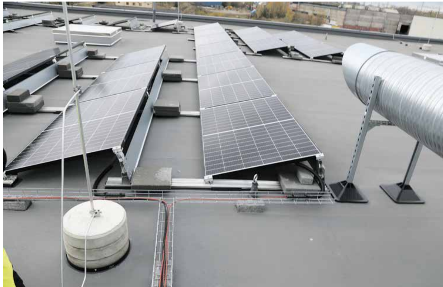
Kaablid ja juhtmed on paigaldatud vett läbilaskvatele rennidele, mis toetuvad katusele spetsiaalsetele alustele. (Eesti). Kaablirennid võiks olla pealt kaetud.
