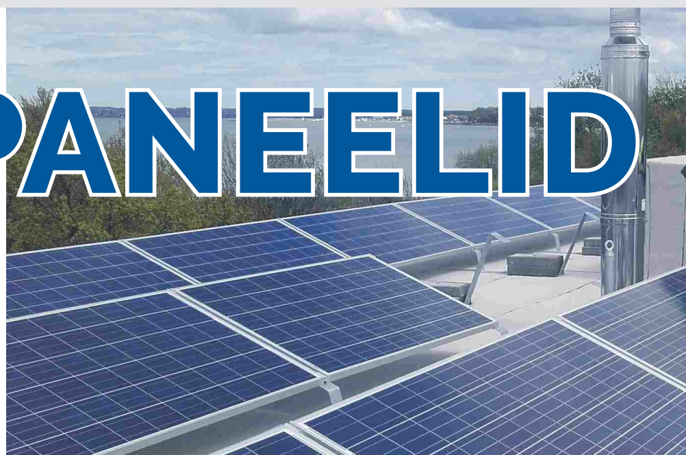
Lattrauast paneelide alus on kohati otse katusekattel. Kinnitused läbivad katusekatet. Selline paigaldusviis on katusekattele kahjulik.
