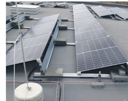
Modifitseeritud bituumenrollmaterjali (MBR) peale MBR lappidega paigaldatud päikesepaneelide alus. Selline lahendus kasutamine eeldab katuse kinnituse arvutusi.
