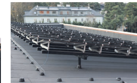
Modifitseeritud bituumenrollmaterjali (MBR) peale MBR lappidega paigaldatud päikesepaneelide alus. Selline lahendus kasutamine eeldab katuse kinnituse arvutusi.
