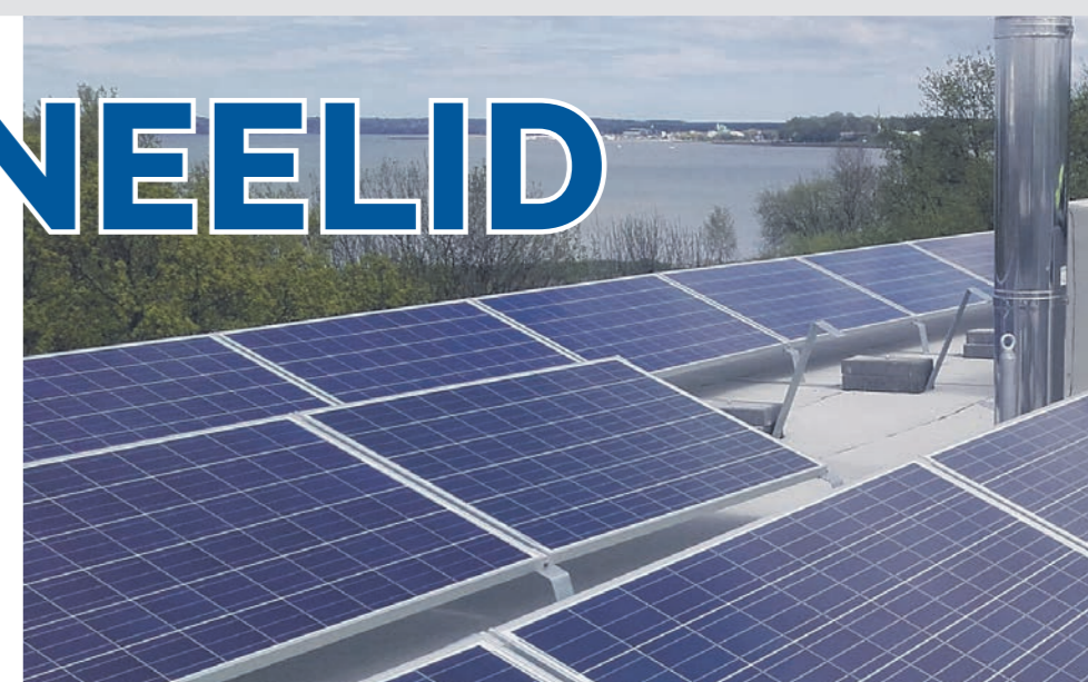
Lattraust paneelide alus on kohati otse katusekattel. Kinnitused läbivad katusekatet. Selline paigaldusviis on katusekattete kahjulik.
