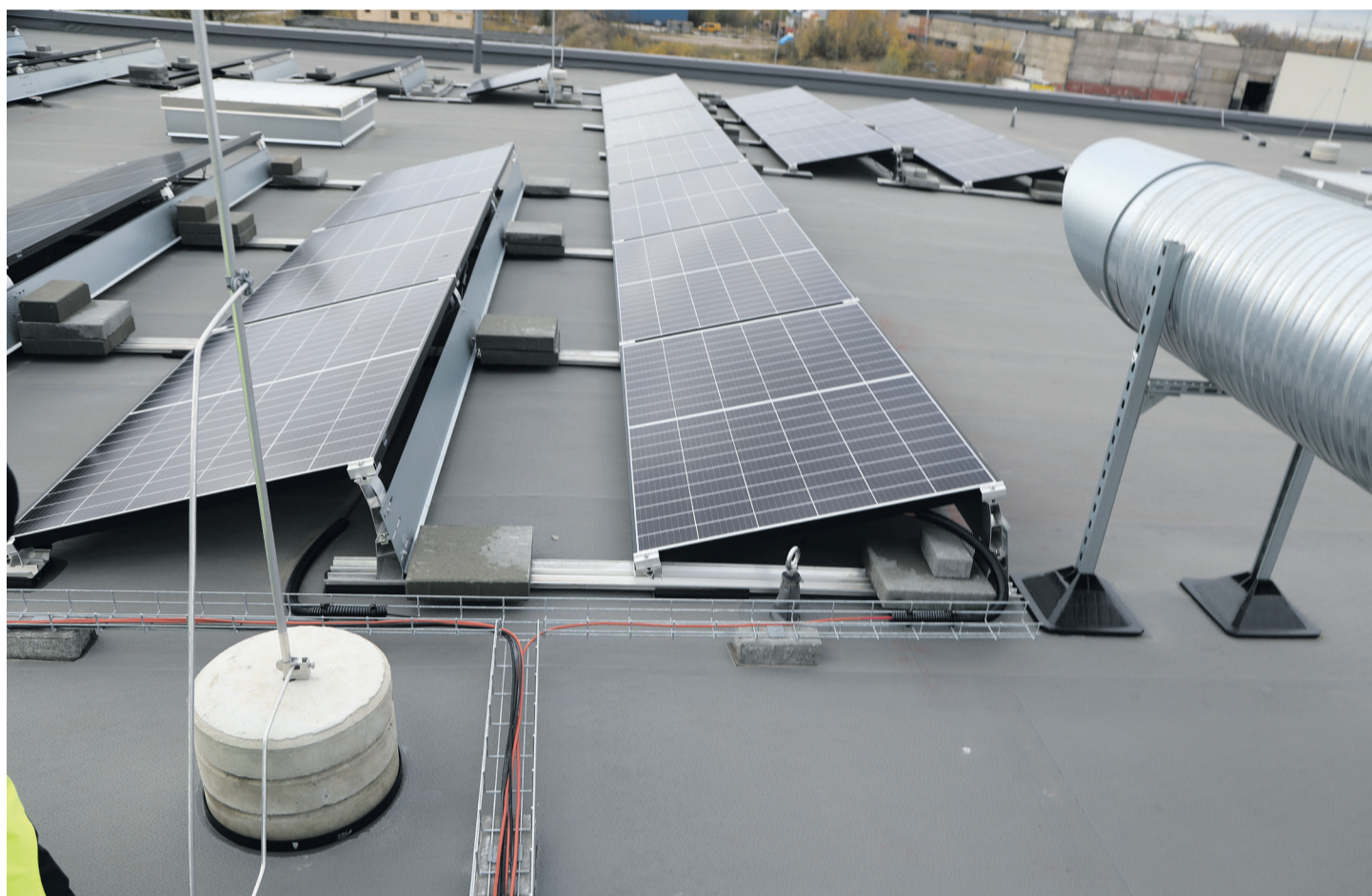
Kaablid ja juhtmed on paigaldatud vett läbilaskvatele rennidetele, mis toetuvad katusele spetsiaalsetele alustele. (Eesti). Kaablirennid võiks olla pealt kaetud.
