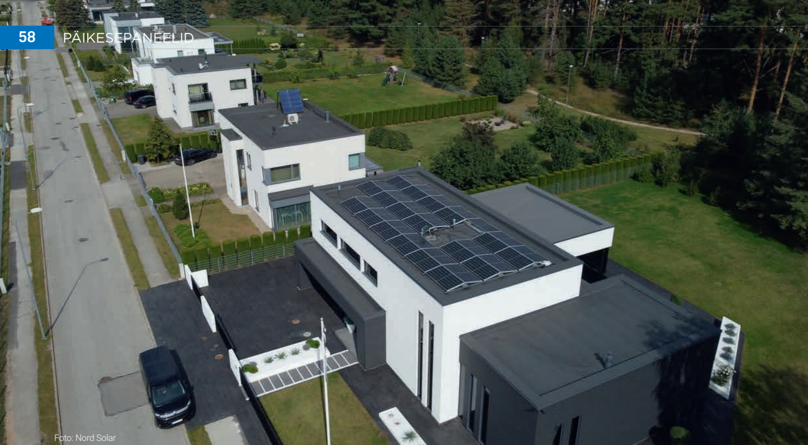
Foto: Nord Solar
