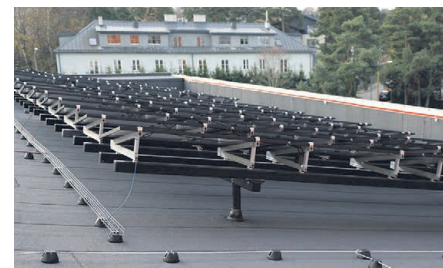
TalTech Mäemaja päikesepaneelid on paigaldatud aluskonstruktsioonidele toetuvatele pollartitele. See tekitab küll marginaalsed külmasillad, kuid võimaldab korrektset katuse hooldust. Hoonel on kõrged parapetid ja seepärast ei ole vaja ka turvavarustust.
