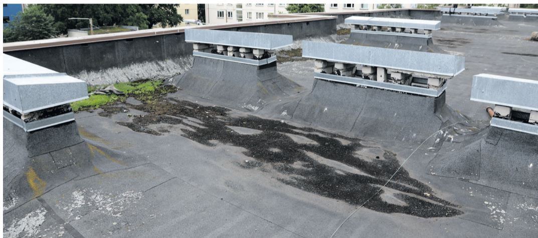
Halvasti õnnestunud katuse remondilahendus ja halb hooldus on viinud katuse enneaegselt kapitaalsete remondi vajaduseni.
