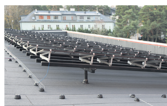
TalTech Mäemaja päikesepaneelid on paigaldatud aluskonstruktsioonidele toetuvatele pollaritele. See tekitab kõrgi marginaalsed külmasillad, kuid võimaldab korrektselt katuse hooldust. Hoonel on kerged parapetid ja seepärast ei ole vaja ka turvavarustust.
