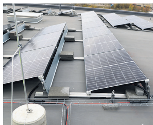
Kaablid ja juhtmed on paigaldatud vett läbilaskvatele rennidele, mis toetuvad katusele spetsiaalsetele alustele. Eestis. Kaablirennid võiks olla pealt kaetud.
