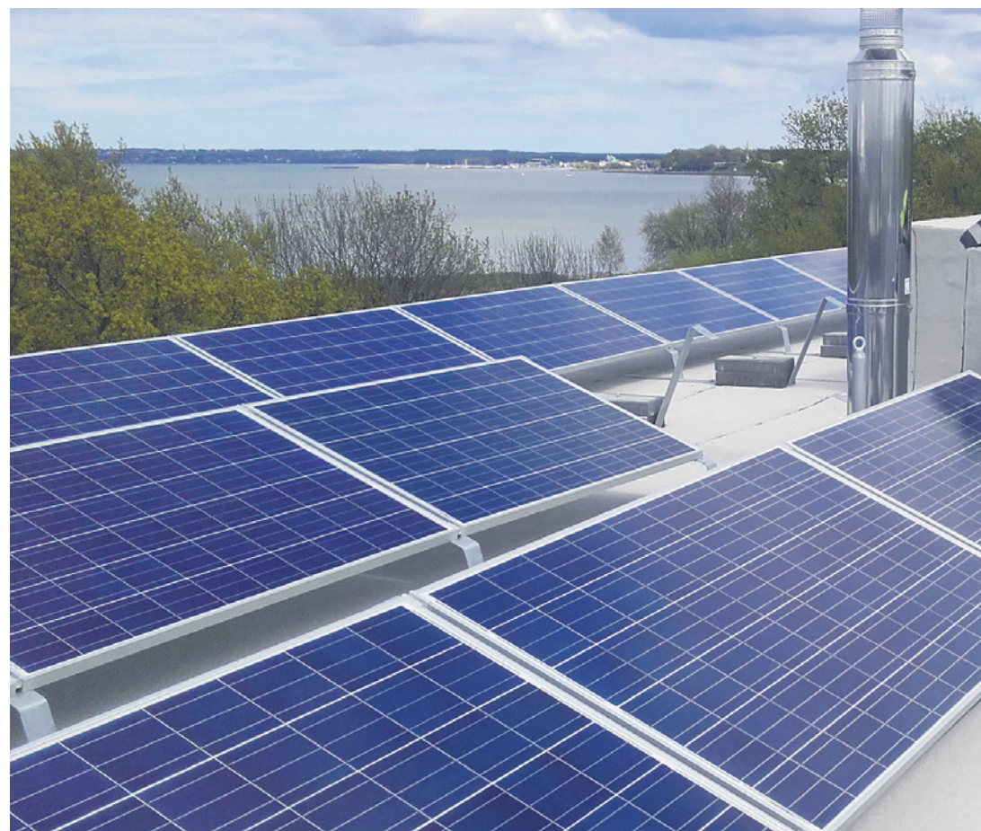
Lattrauast paneelide alus on kohati otse katusekattel. Kinnitused läbivad katusekatet. Selline paigaldusviis on katusekattele kahjulik.
