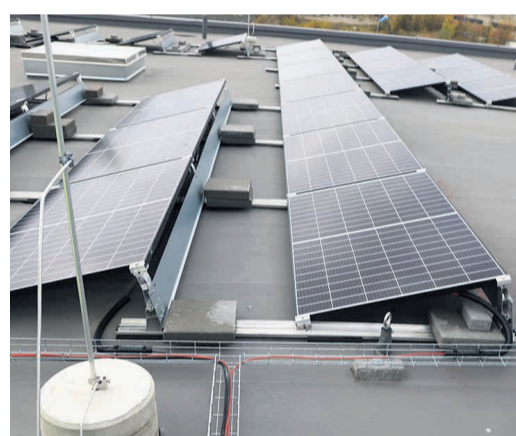
Kaablid ja juhtmed on paigaldatud vett läbilaskvatele rennidetele, mis toetuvad katusele spetsiaalsetele alustele. (Eesti). Kaablirennid võiks olla pealt kaetud.
