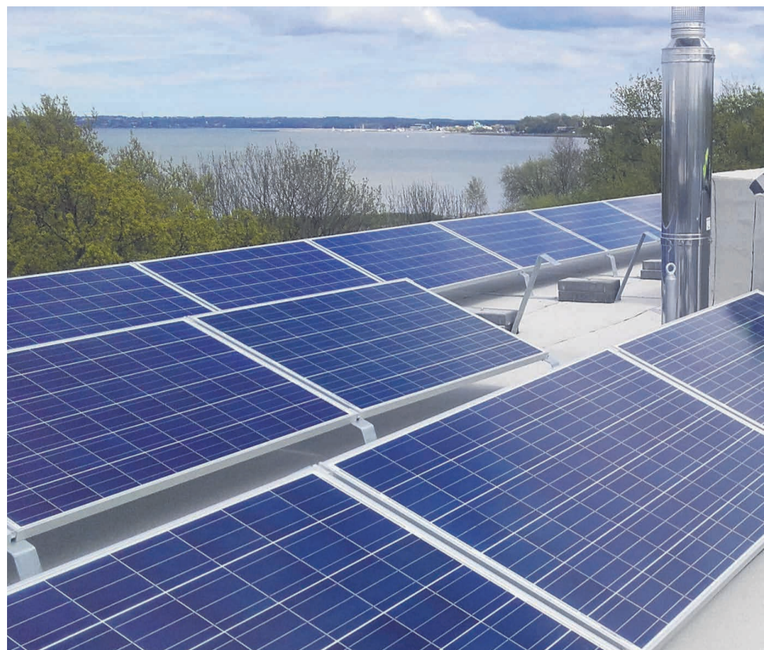
Lattraust paneelide alus on kohati otse katusekattel. Kinnitused läbivad katusekatet. Selline paigaldusviis on katusekattele kahjulik.
