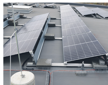
Kaablid ja juhtmed on paigaldatud vett läbitaskvatele rennidele, mis toetuvad katusele spetsiaalsetele alustele. (Eesti). Kaablirennid võiks olla pealt kaetud.
