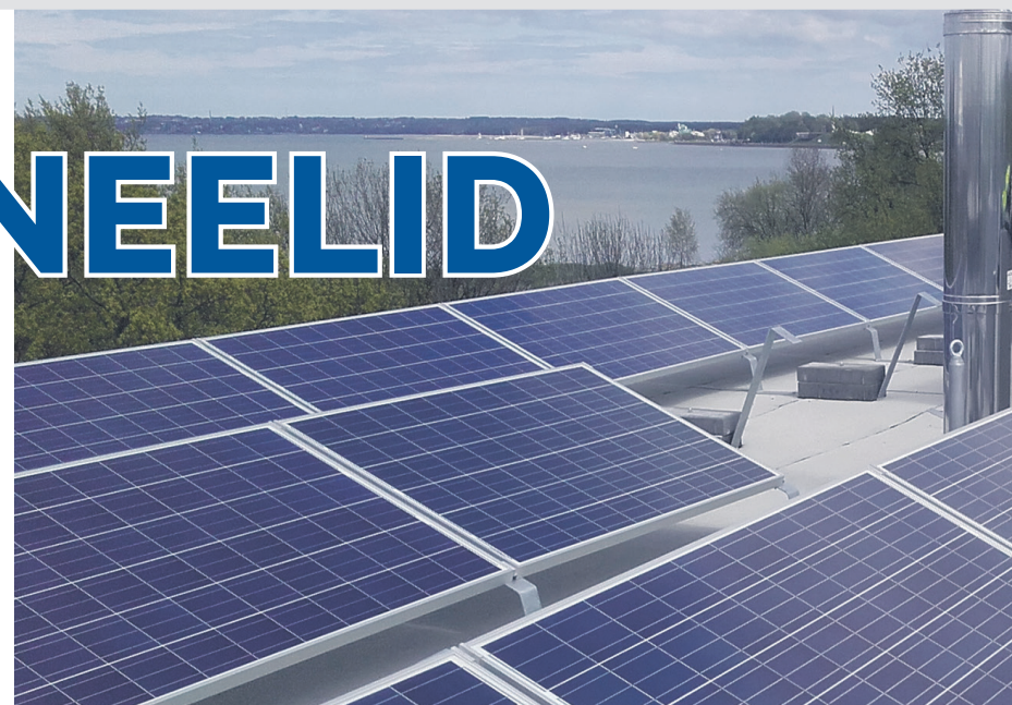
Lattrauast paneelide alus on kohati otse katusekatel. Kinnitused läbivad katusekatet. Selline paigaldusviis on katusekattele kahjulik.
