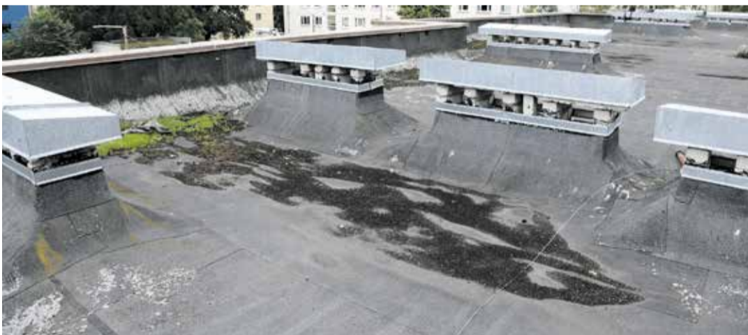
Halvasti õnnestunud katuse remondilahendus ja halb hooldus on viinud katuse enneaegselt kapitaalset remonti vajaduseni.
