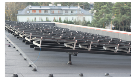
TalTech Mäemaja päikesepaneelid on paigaldatud aluskonstruktsioonidele toetuvatele pollaritele. See tekitab küll marginaalsed külmasilad, kuid võimaldab korrektselt katuse hooldust. Hoone on kõrge parapetid ja seepärast ei ole vaja ka turvavarustust.
