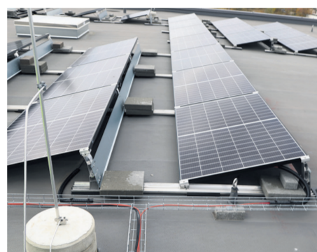
Kaablid ja juhtmed on paigaldatud vett läblaskvatele rennidelle, mis toetuvad katusele spetsiaalsetele alustele. (Eesti). Kaablirennid võiks olla pealt kaetud.
