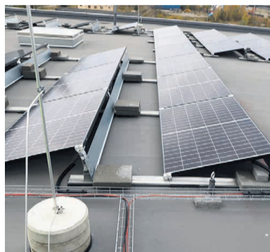
Kaablid ja juhtmed on paigaldatud vett läbilaskvatele rennidele, mis toetuvad katusele spetsiaalsetele alustele. Eesti. Kaablirennid võiks olla pealt kaetud.
