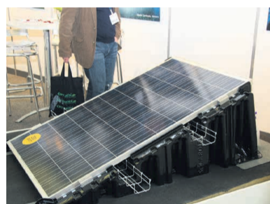
Modifitseeritud bituumenrullmaterjali (MBR) peale MBR-lappidega paigaldatav päikesepaneeli alus. Sellise lahenduse kasutamine eeldab katuse kinnituse arvutusi.
