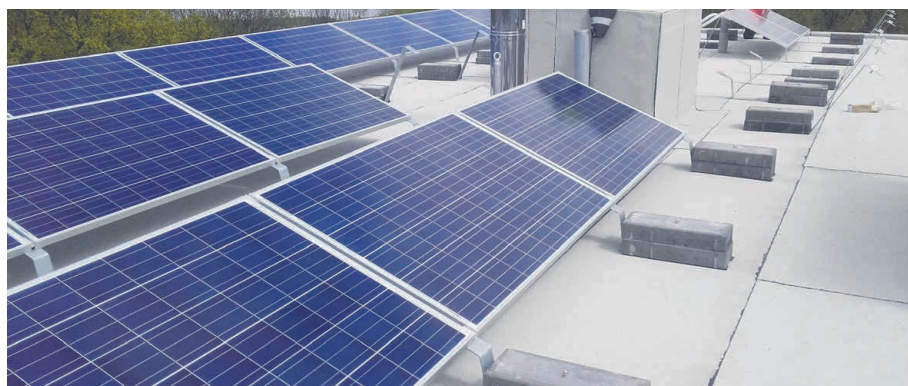
Lattrauast paneelide alus on kohati otse katusekattel. Kinnitused läbivad katusekatet. Selline paigaldusviis on katusekattele kahjulik.
