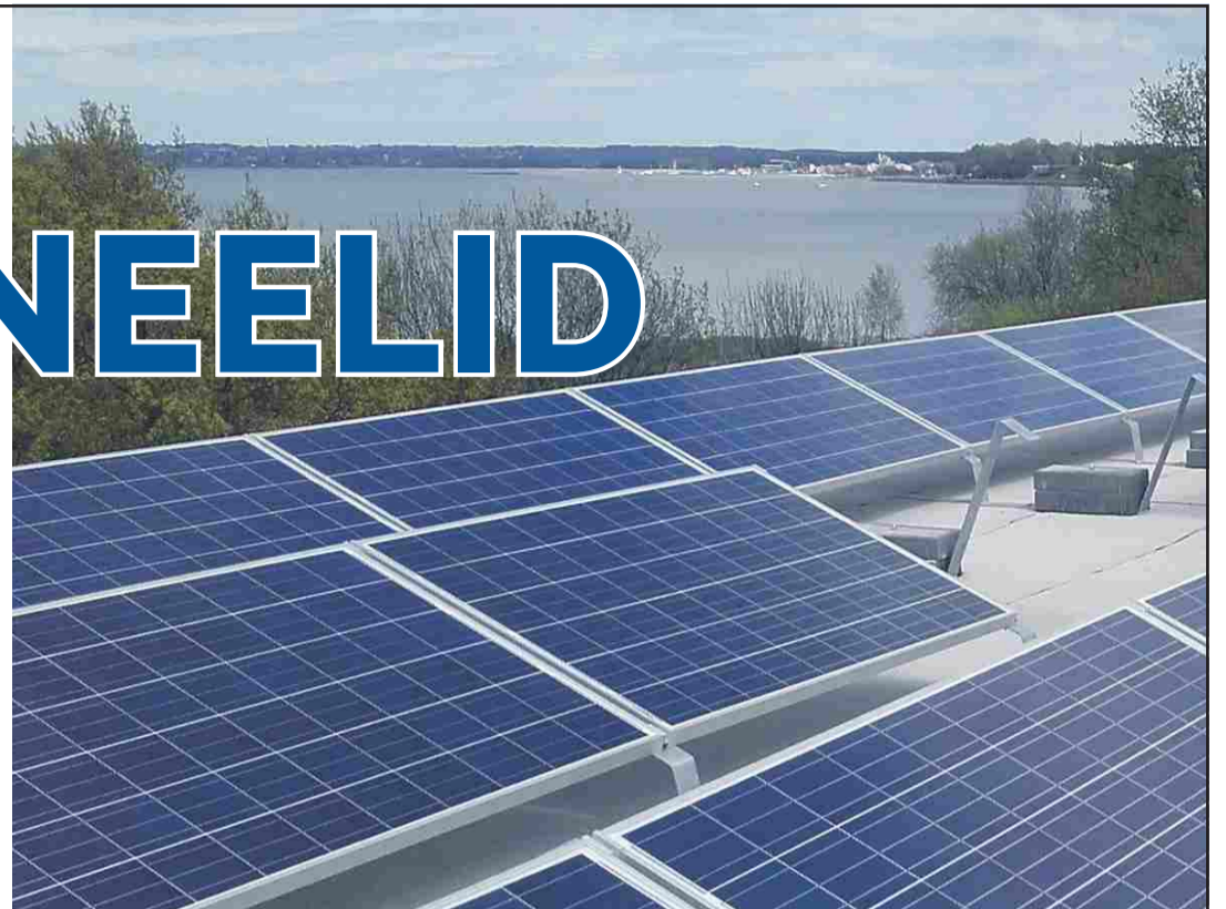
Lattrauast paneelide alus on kohati otse katusekattel. Kinnitused läbivad katusekatet. Selline paigaldusviis on katusekattele kahjulik.
