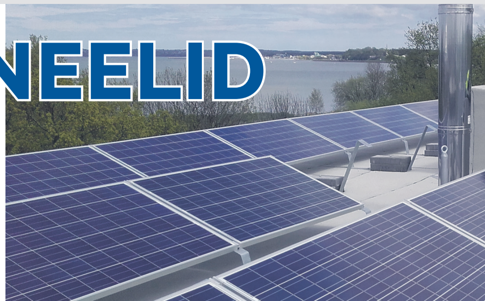
Lattruust paneelide alus on kohati otse katusekattel. Kinnitused läbivad katusekatet. Selline paigaldusviis on katusekattele kahjulik.
