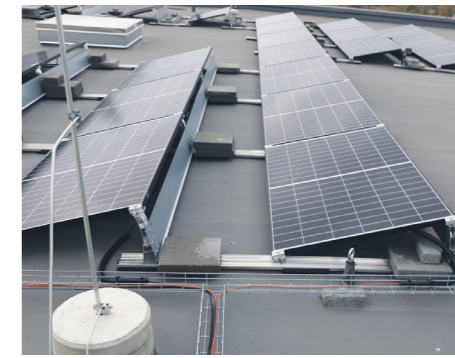
Kaablid ja juhtmed on paigaldatud vett läbilaskvatele rennidetele, mis toetuvad katusele spetsiaalsetele alustele. (Eesti). Kaablirennid võiks olla pealt kaetud.
