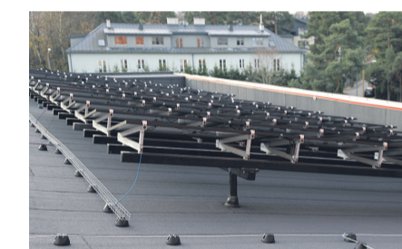
TalTech Mäemaja päikesepaneelid on paigaldatud alusstruktuuridele toetuvatele pollaritele. See tekitab küll marginaalseid külmasillaid, kuid võimaldab korrektset katuse hooldust. Hoone on kõrgeid parapetteid ja seepärast ei ole vaja ka turvarakendust.
