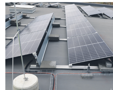
Kaablid ja juhtmed on paigaldatud vett läbilaskvatele rennidelle, mis toetuvad katusele spetsiaalsetele alustele. (Eesti). Kaablirennid võiks olla pealt kaetud.
