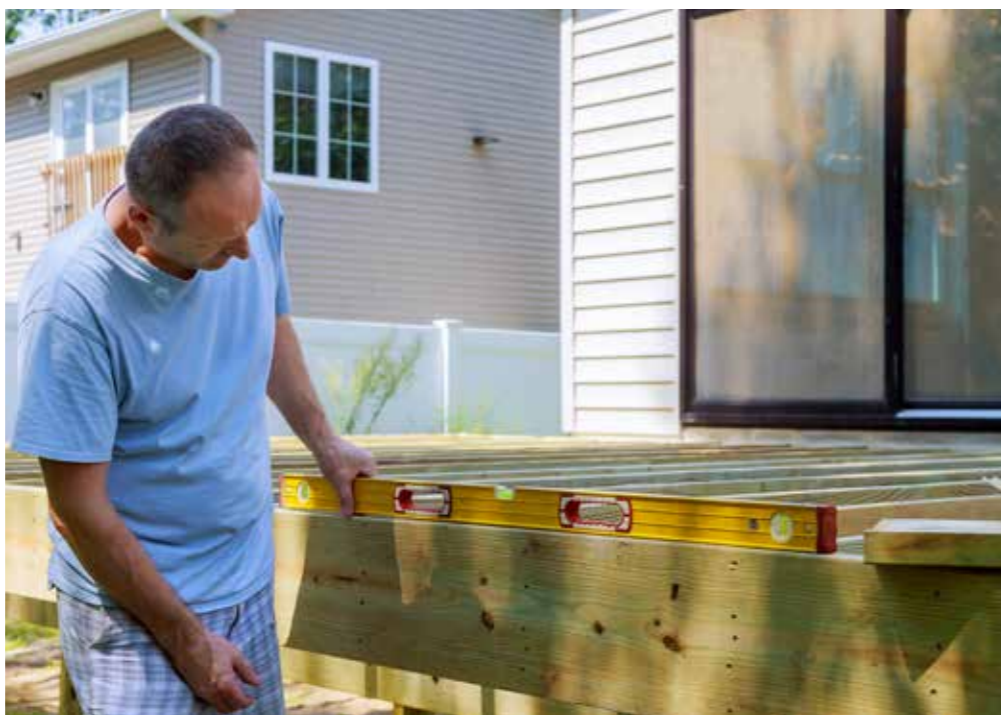
Loodi jääb Eesti tingimustes terrass, mille vundament ulatub allapoole külmumispiiri.
