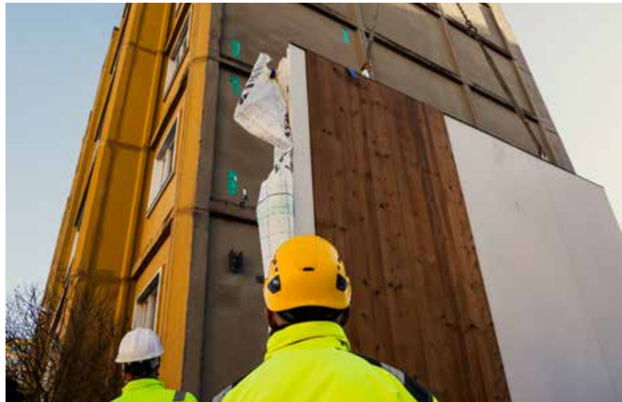
Projekti oPEN Lab raames paigaldati Annelinna üheksakorruselise maja otsaseinale tehases eeltoodetud paneelid, et mõõta nende sobivust ja tõhusust.
