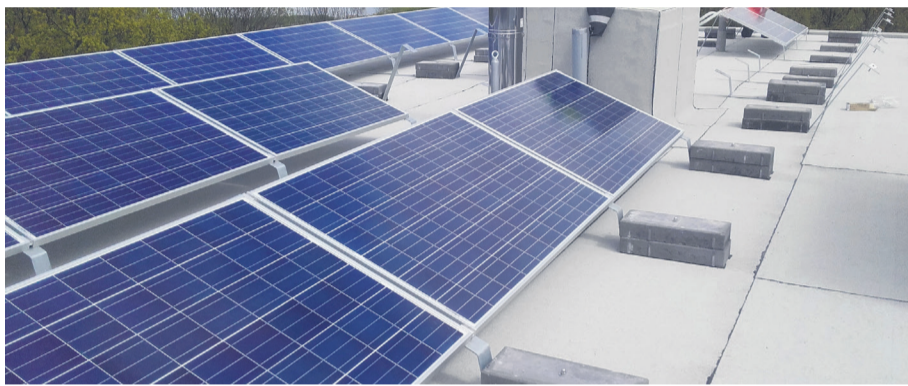
Lattrauast paneelide alus on kohati otse katusekattel. Kinnitused läbivad katusekatet. Selline paigaldusviis on katusekattete kahjulik.
