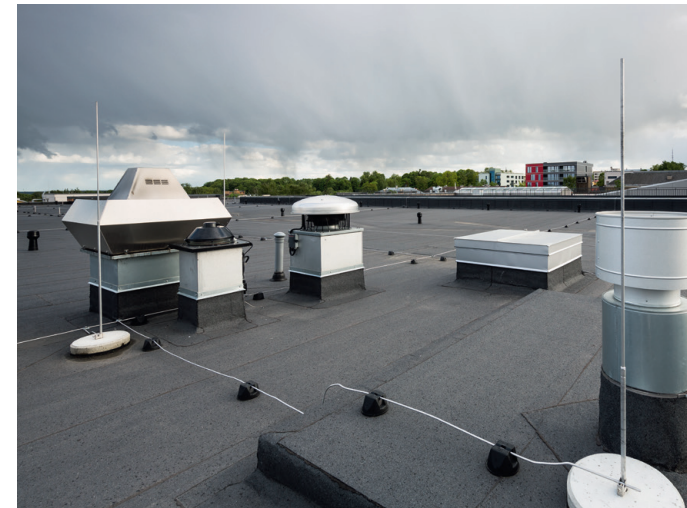
Katuse läbiviigid. Foto: OÜ Evari Ehitus
