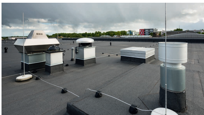
Katuse läbiviigid. Foto: OÜ Evari Ehitus
