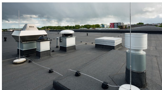
Katuse läbiviigid. Foto: OÜ Evari Ehitus
