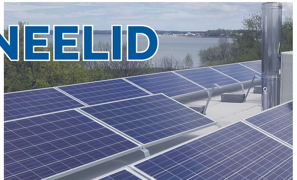
Lattrauast paneelide alus on kohati otse katusekattel. Kinnitused läbivad katusekatet. Selline paigaldusviis on katusekattele kahjulik.
