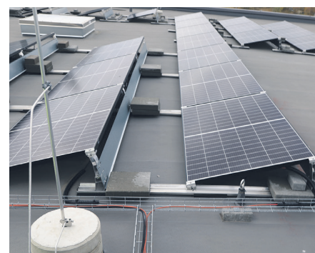
Kaablid ja juhtmed on paigaldatud vett läbilaskvatele rennidele, mis toetuvad katusele spetsiaalsetele alustele. (Eesti). Kaablirennid võiks olla pealt kaetud.
