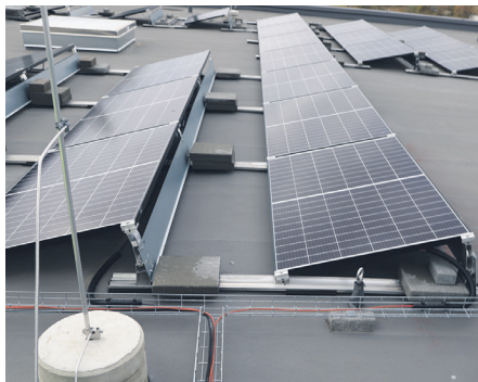
Kaablid ja juhtmed on paigaldatud vett läbi- laskvatele rennidelle, mis toetuvad katusele spetsiaalsetele alustele. (Eesti). Kaablirennid võiks olla pealt kaetud.
