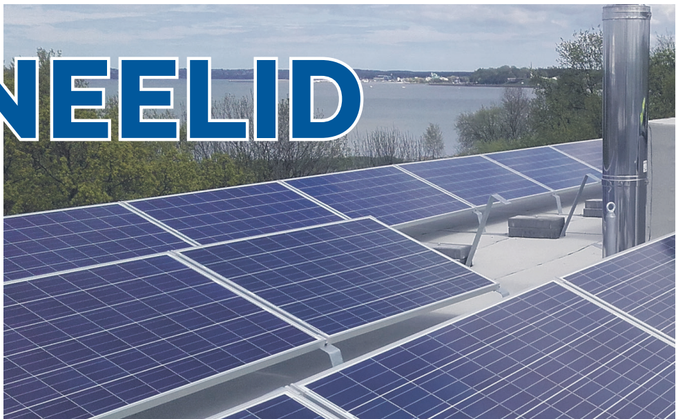
Lattraust paneelide alus on kohati otse katusekattel. Kinnitused läbivad katusekatet. Selline paigaldusviis on katusekattele kahjulik.
