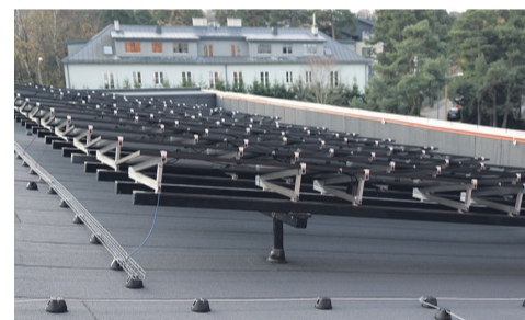
TalTech Mäemaja päikesepaneelid on paigaldatud alusstruktuuridele toetuvatele pollaritele. See tekitab küll marginaalsed külmasillad, kuid võimaldab korrektset katuse hooldust. Hoonel on kõrged parapetid ja seepärast ei ole vaja ka turvavarustust.
