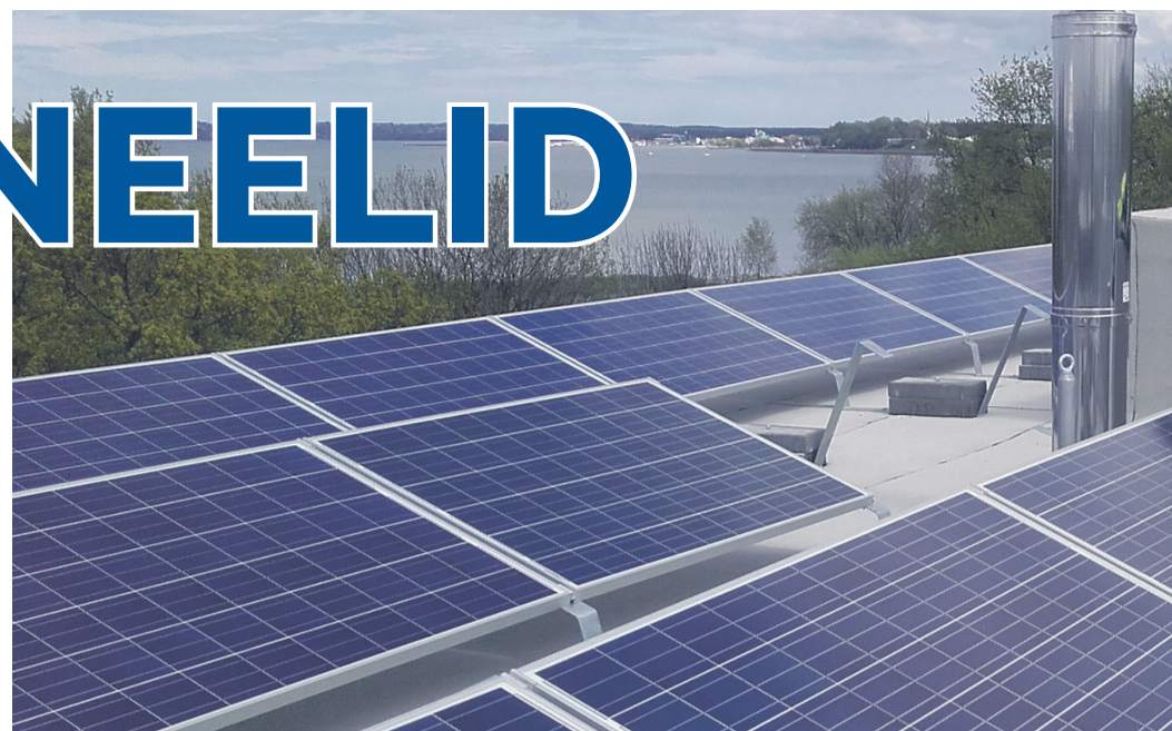
Lattrauast paneelide alus on kohati otse katusekatel. Kinnitused läbivad katusekatet. Selline paigaldusviis on katusekattele kahjulik.
