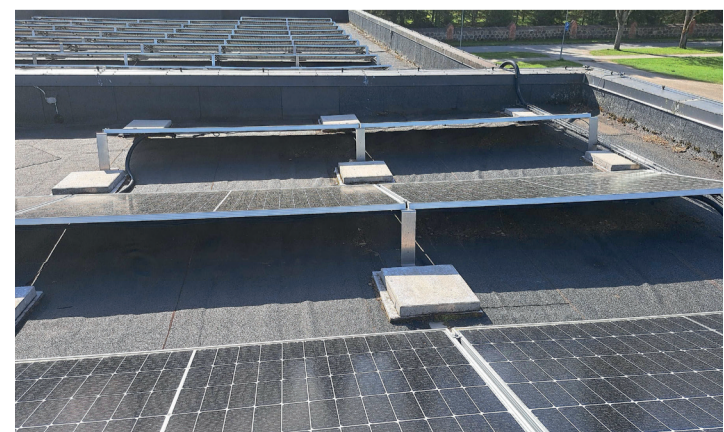
Päikesepaneelide jalad on katusekatet kahjustanud ning prahi on kogunenud paneelide alla.
