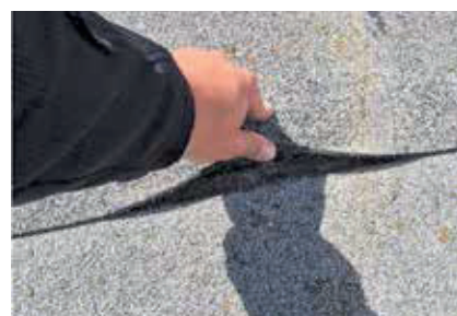
Ebakorrekse paigalduse tõttu lahti tulnud rullmaterjal – kogu katus tuleb uue kihiga katta.
