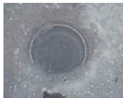
Ummistunud katusekaev talvel. Lähijäätmisel võib katusekaev puruneda. Tuleb veenduda, et kaevu küttekabel on talvel sisse lülitatud.
