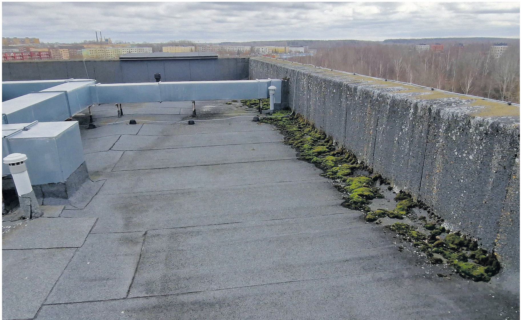
Aastaid hooldamata katusel võivad hakata kasvama sammal, puud ja muud taimed. Seejuures on oluline katusel tekkinud rohelist eemaldades olla ettevaatlik, et mitte kahjustada katusekatet.
