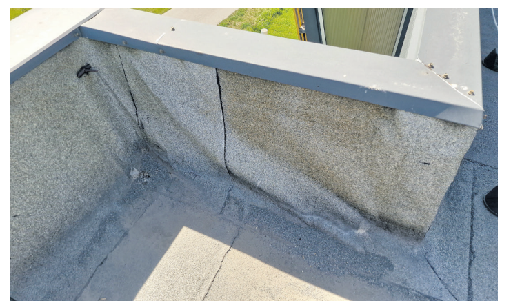
Kortsus ja halvas seisus parapeti ülespööre, mis tekitab lume sulamisel uputuse. Vajalik teostada põhjalik renoveerimine.
