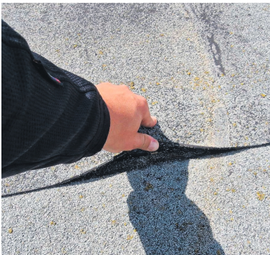
Ebakorrekse paigalduse tulemusena lahti tulnud rullmaterjal, kogu katus tuleb uue kihiga katta.
