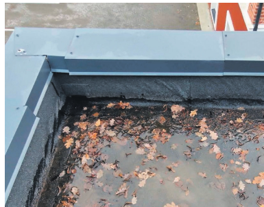
Lehed tuleb sügisel eemaldada, et vältida vee äravoolu takistamist. Antud pildil on näha, et pleki- ja rullmaterjalitööd on teostatud ebakorrektselt ning risk leketeks on suur.
