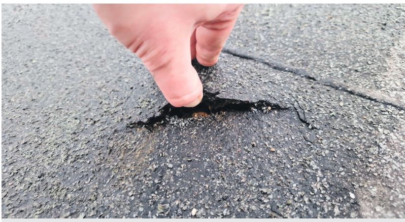
Katusel toimunud tegevuse käigus on katusekatet kahjustatud. Sellised kohad tuleb kiiremas korras paigata, et vältida suuremaid kahjustusi.
