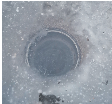
Ummistunud katusekaev talvel. Lähijäätumisel võib katusekaev puruneda. Tuleb veenduda, et kaevu küttekaabel on talvel sisse lülitatud.
