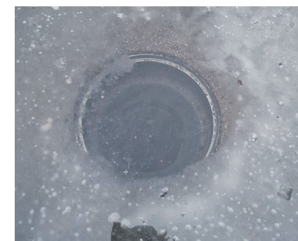
Ummistunud katusekaev talvel. Lähijäätumisel võib katusekaev puruneda. Tuleb veenduda, et kaevu küttegaabel on talvel sisse lülitatud.
