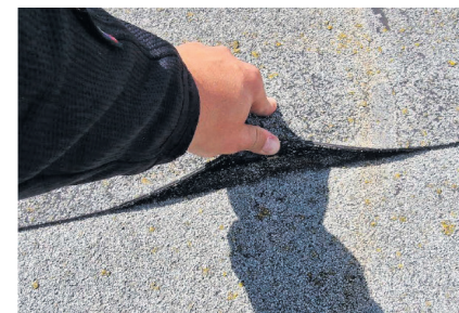
Ebakorrekse paigalduse tõttu lahti tulnud rullmaterjal – kogu katus tuleb uue kihiga katta.
