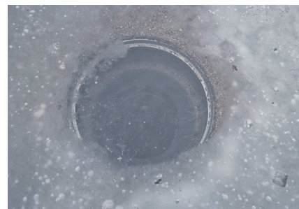
Засоренная воронка на крыше зимой. При обледенении воронка может треснуть. Убедитесь, что зимой нагревательный кабель в воронке включен.
