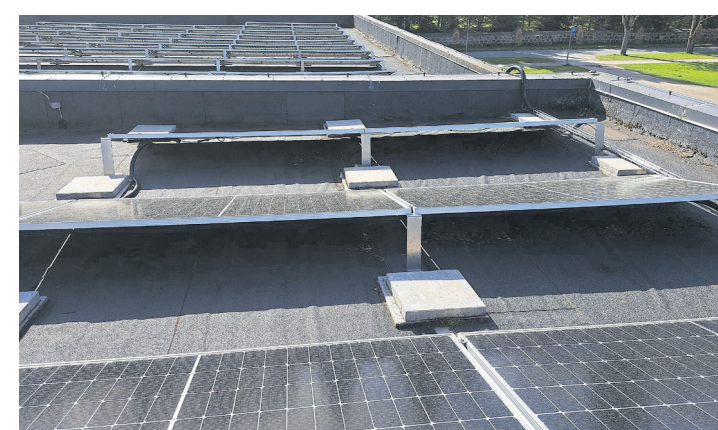
Päikesepaneelide jalad on katusekatet kahjustanud ning prahit on kogu- nenud paneelide alla.
