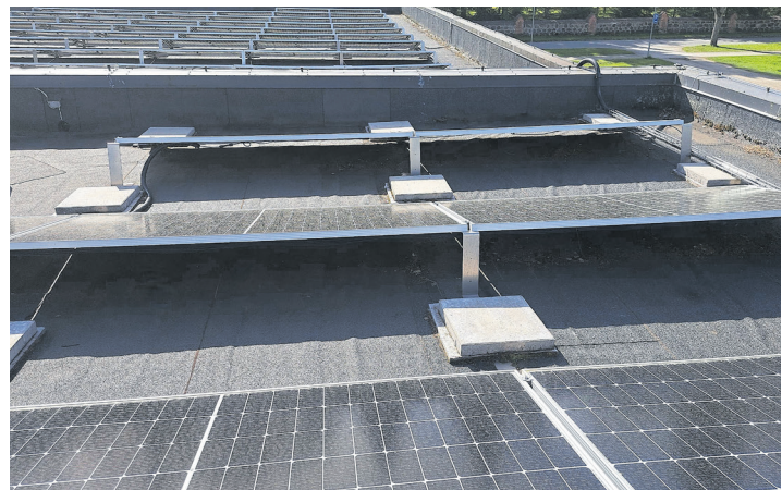
Päikesepaneelide jalad on katusekatet kahjustanud ning praht on kogunenud paneelide alla.
