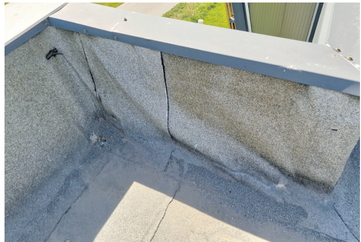
Kortsus ja halvas seisus parapeti ülespööre, mis tekitas lume sulamisel uputuse. Vajalik teostada põhjalik renoveerimine.
