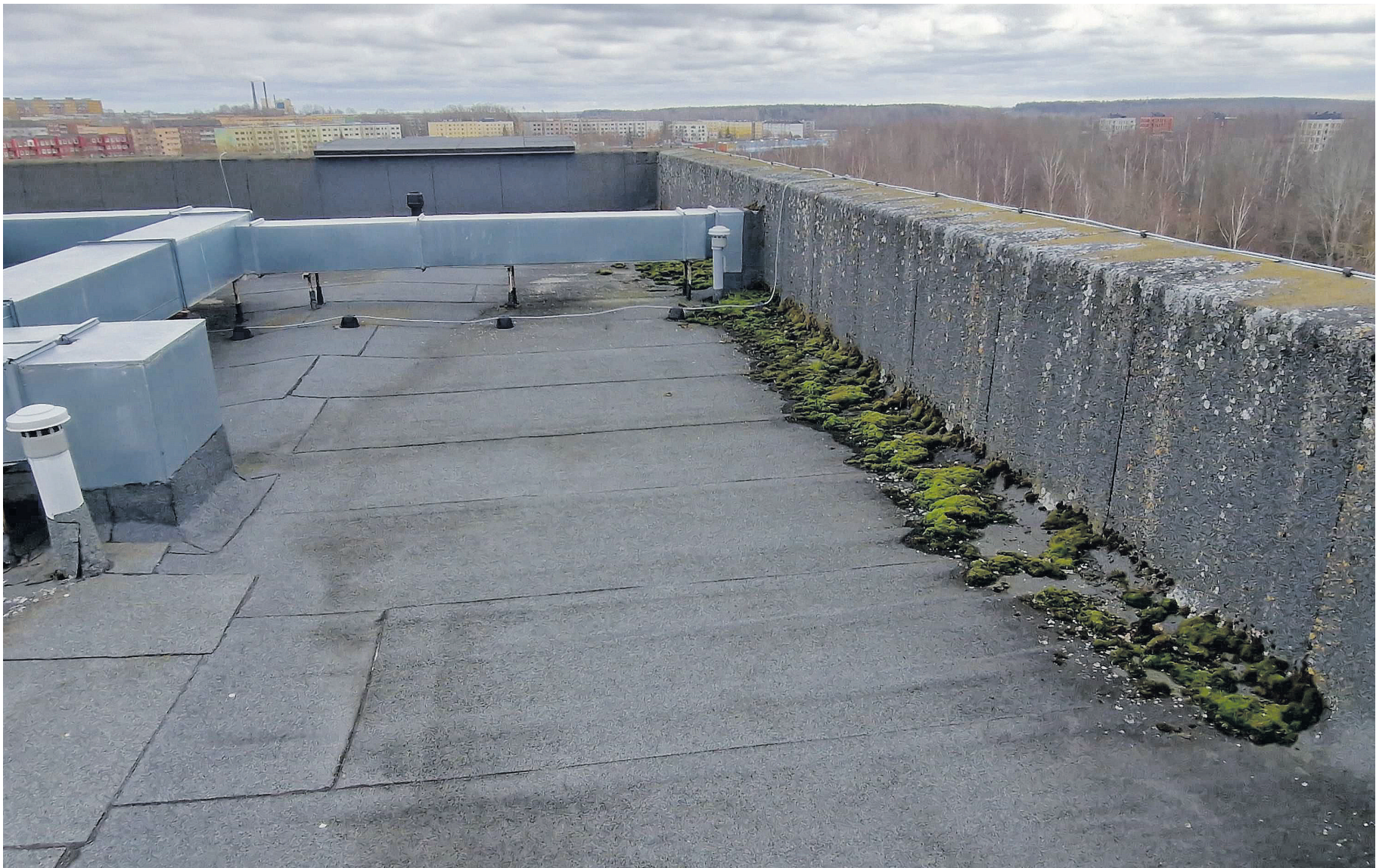
Aastaid hooldamata katusel võivad hakata kasvama sammal, puud ja muud taimed. Seejuures on oluline katusel tekkinud rohelust eemaldades olla ettevaatlik, et mitte kahjustada katusekatet.
