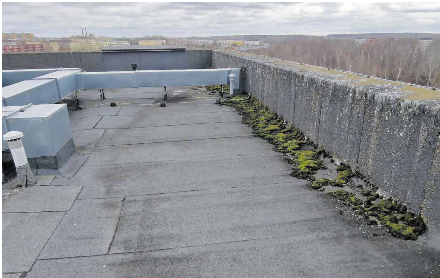
Aastaid hooldamata katusel võivad hakata kasvama sammal, puud ja muud taimed. Seejuures on oluline katusel tekkinud rohelist eemaldades olla ettevaatlik, et mitte kahjustada katusekatet.
