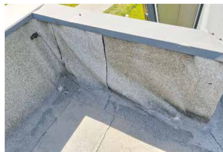
Kortsus ja halvas seisus parapeti ülespööre, mis tekitab lume sulamisel uputuse. Vajalik teostada põhjalik renoveerimine.
