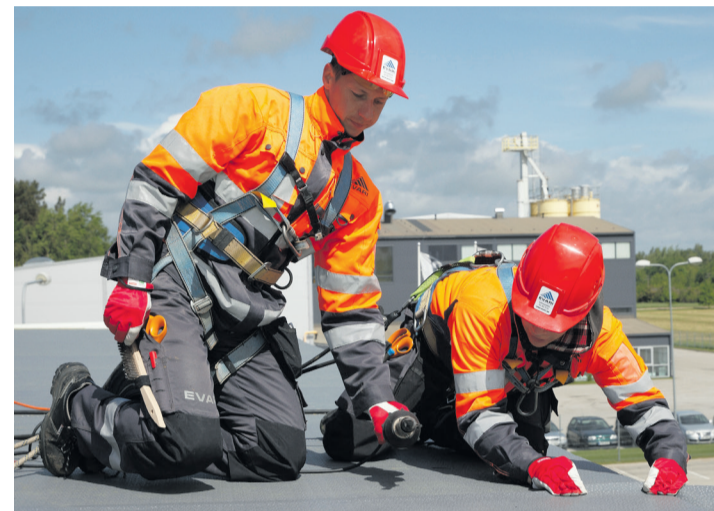
Kuna katuse eluiga on äärmiselt tähtis, tuleb kasutada kvaliteetseid materjale, korralikke lahendusi ning paigaldusel oma ala asjatundjaid.
