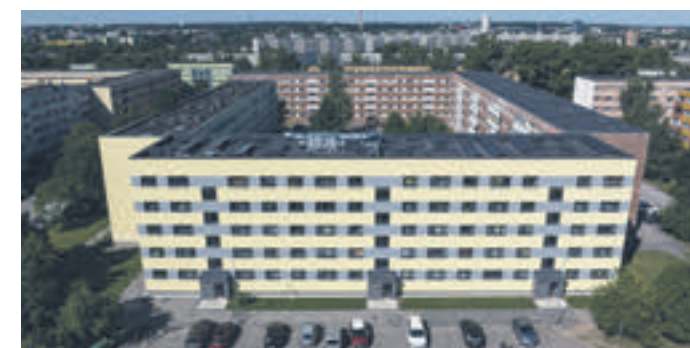
Многоквартирные дома в Тарту на бульваре Каунасе
