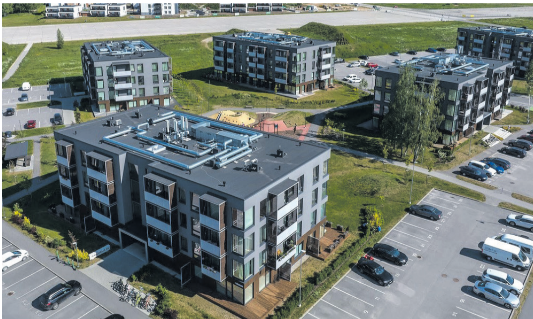
Paigaldatud tehnosüsteemid lamekatusel ja kaasaegse sundventilatsiooni jaotussüsteemi integreerimine uute korterelamute katusepindadele Raadi linnaosas. Fotod: OÜ Evari Ehitus
