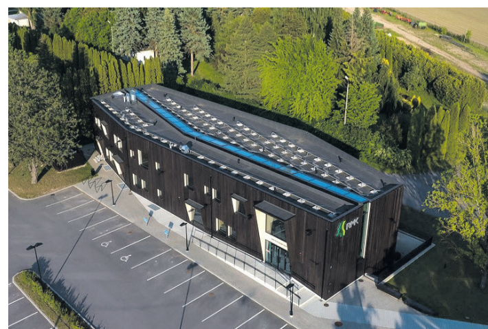
Tehnosüsteemide paigaldamine lamekatusele ja bituumenist hüdroisolatsioonikihi koormustaluvuse tagamine RMK peahoone unikaalsel puitarhitektuuriga ehitisel Tartus.
