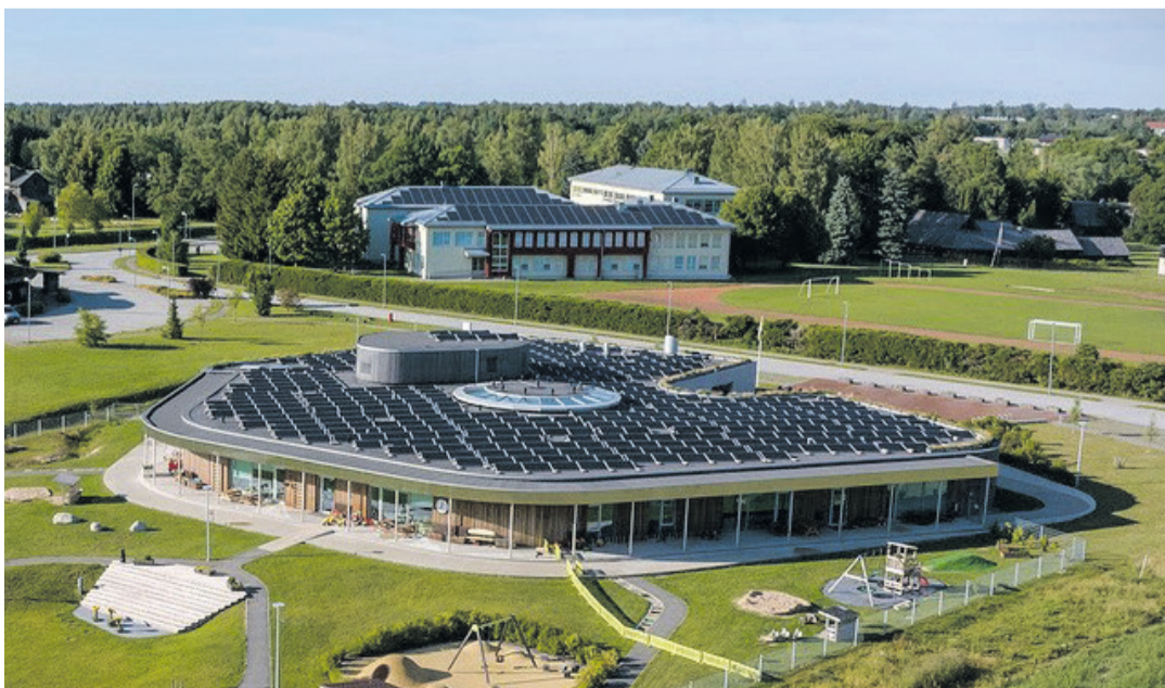
Tehnosüsteemide paigaldamine lamekatusele ja mastaapne päikesepaneelide park Palamuse lasteaia ümber kujuga modernsel hoonel Jõgeva vallas.
