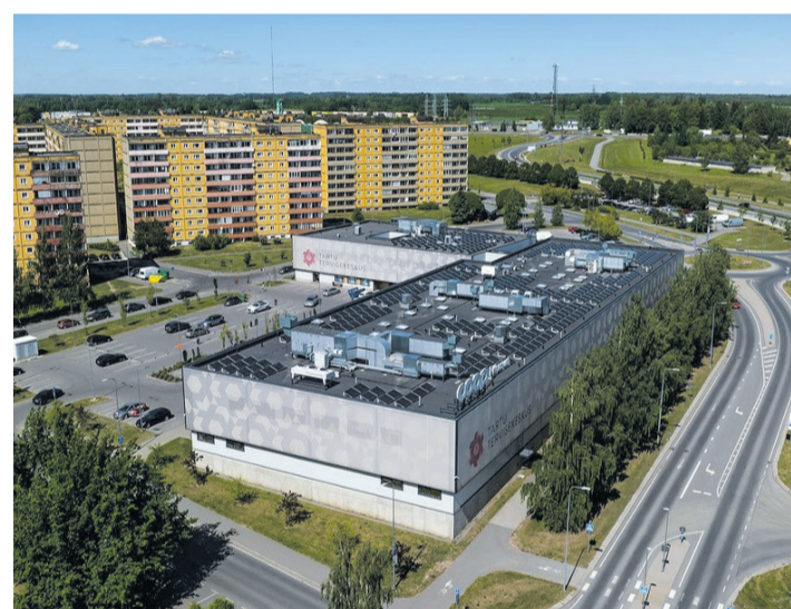
Tehnosüsteemid ja kombineeritud tehnosõlmede võrgustik lamekatusel Tartu tervisekeskuse ja COOP-i kaupluse mastaapsel L-kujulisel hoonekompleksil Tartus.
