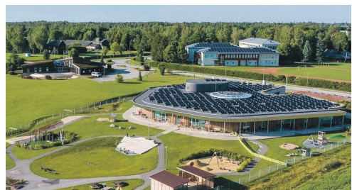
Tehnosüsteemide paigaldamine lamekatusetele ja mastaapne päikesepaneelide park Palamuse lasteaia ümara kujuga modernsel hoonel Jõgeva vallas.
