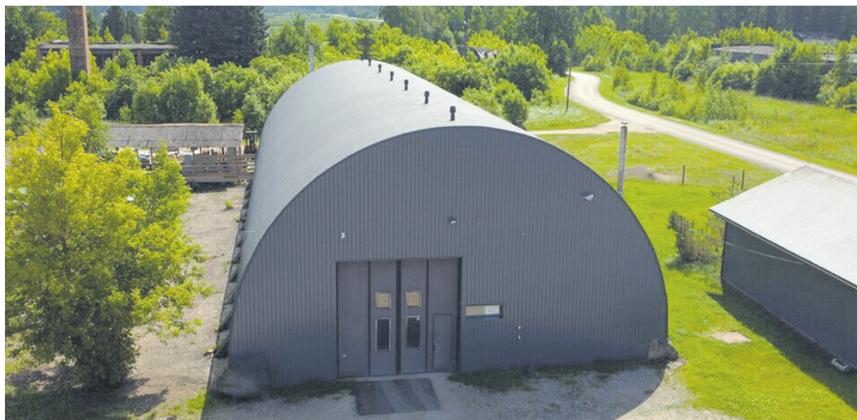
Täielikult korda tehtud ja soojustatud hoone on pärast kaarhalli renoveerimist valmis toimima energiatõhusa tootmis- või laohoonena.
