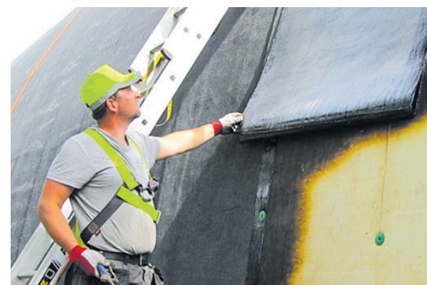
Katusespetsialist paigaldab kaarhalli soojustuskihile bituumenrullmaterjalist hüdroisolatsioonikihti, tagades rullide korrektse ülekatte ja mehaanilise kinnituse.
