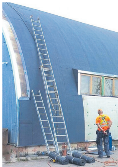
OÜ Evari Ehitus meistrid muudavad vana ja lekkiva angaari kaarhalli renoveerimise käigus kaasaegseks äripinnaks.
